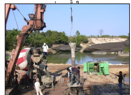
รูปที่ ๕-๔๖ โฟม และของเหลวในหลุม ถูกดันโดยคอนกรีต ให้ล้นออกด้านบน
