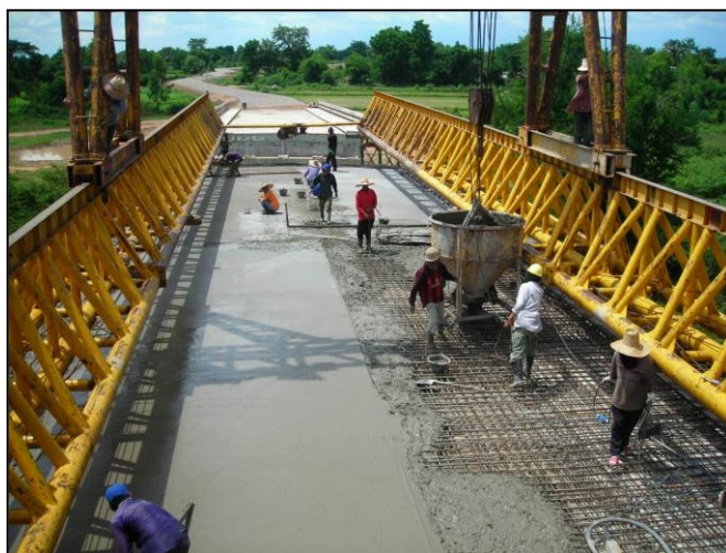
รูปที่ ๖-๔๙ เทคอนกรีตพื้นสะพานบนคาน I-Girder
