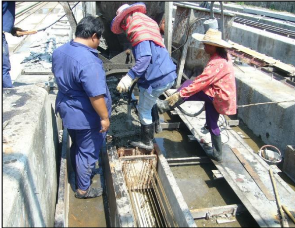
รูปที่ ๕-๑๔ การควบคุมการเทคอนกรีตเสาเข็ม
