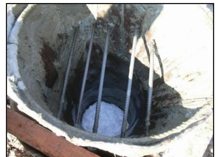
รูปที่ ๕-๔๓ Plug โฟม ใน Trimie Pipe
