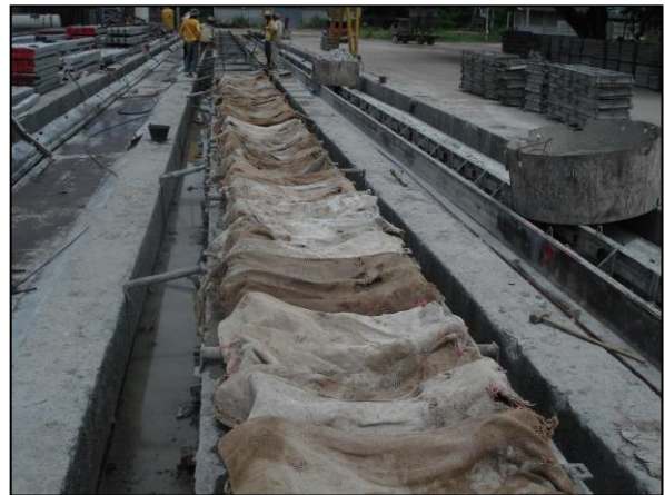
รูปที่ ๖-๒๗ บ่มคอนกรีตตามข้อกำหนด
