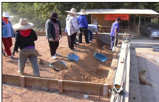
รูปที่ ๗-๖ การถมทรายซับน้ำใต้พื้น Approach Slab
