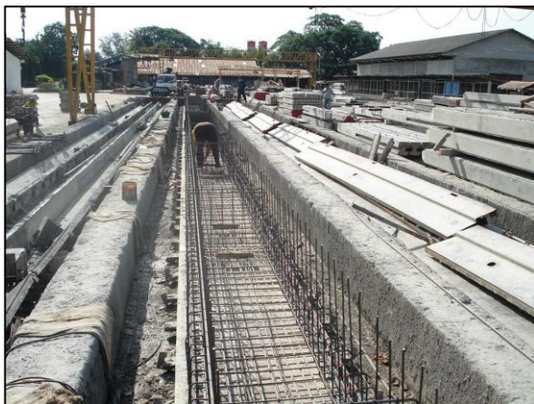
รูปที่ ๖-๒๒ ติดตั้งเหล็กเสริมและลวดอัดแรง
