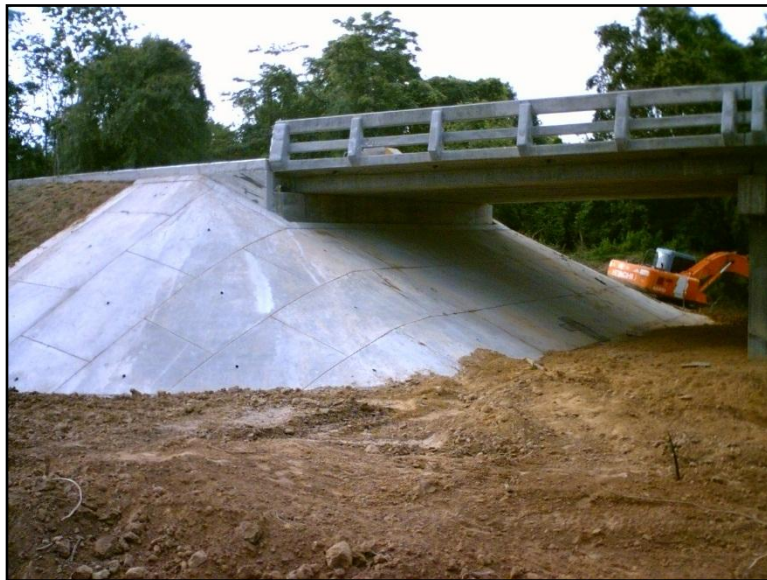
รูปที่ ๗-๔ งานลาดคอนกรีตที่ก่อสร้างแล้วเสร็จ
