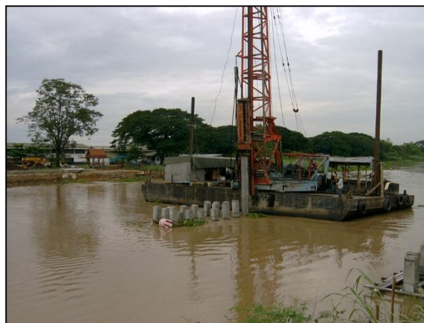
รูปที่ ๕-๑๗ การตอกเสาเข็มโดยใช้โป๊ะแทนนั้้งร้าน
