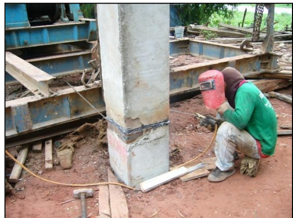
รูปที่ ๕-๒๕ แสดงขั้นตอนการเชื่อมต่อเสาค้ำ
