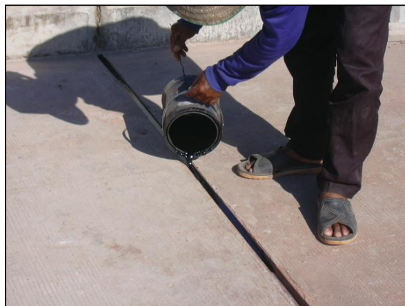
รูปที่ ๖-๕๑ เทวัสดุยาแนวรอยต่อชนิดเทร็อน (Joint Sealant) ตาม มอก.๔๗๙
