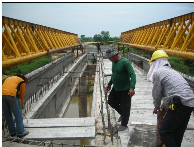
รูปที่ ๖-๔๘ ปรับระดับหลังคานด้วยปูนทราย ก่อนวางแผนพื้นสำเร็จรูป
