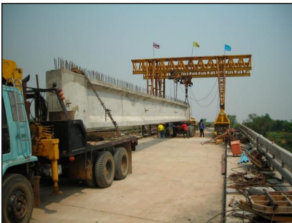
รูปที่ ๖-๔๖ ขนย้ายคานขึ้นสู่สะพานเตรียมการติดตั้ง
