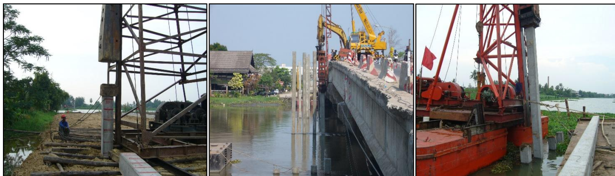
รูปที่ ๕-๑๘ ปั่นจั่นตอกเสาเข็ม (แบบโครงเหล็ก แบบรถตอกเคลื่อนที่ และแบบโป๊ะ)
