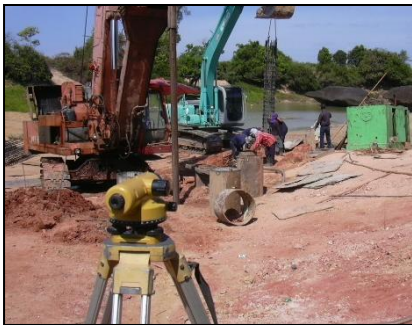
รูปที่ ๕-๓๘ ตรวจสอบแนวตั้งขณะเจาะชั้นหิน
