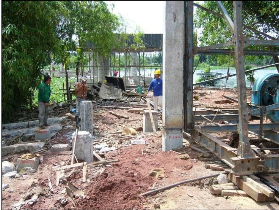
รูปที่ ๕-๒๖ แสดงการเชื่อมต่อเสาเข็มแล้วเสร็จ
