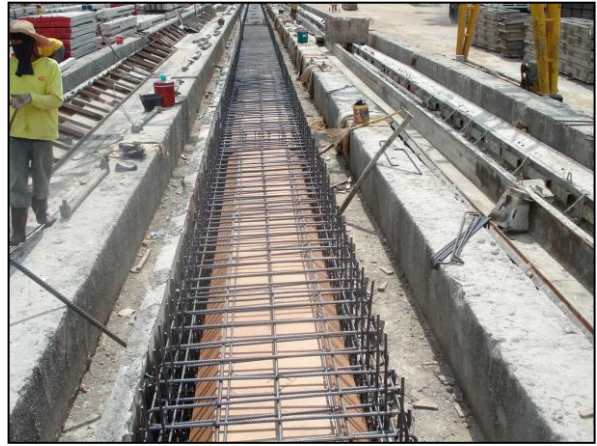
รูปที่ ๖-๒๕ กล่องด้านใน Box Girder
