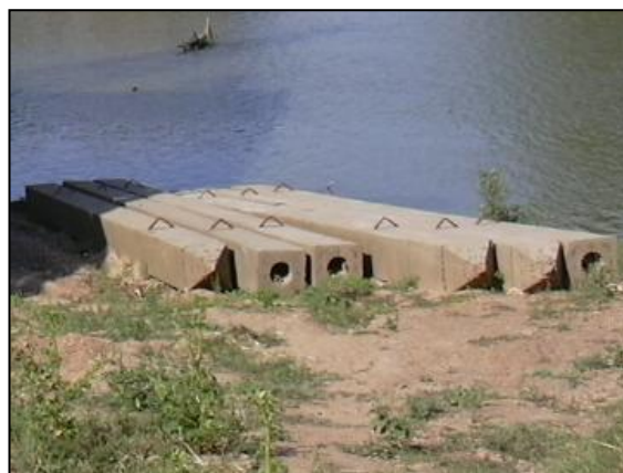
รูปที่ ๕-๒ เสาเข็มหน้าตัดสี่เหลี่ยมกลวง เสริมเหล็กหล่อปลายหล่อเสาเข็ม
