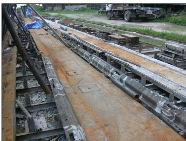
รูปที่ ๖-๖ ตรวจสอบพื้นแบบหล่อ
