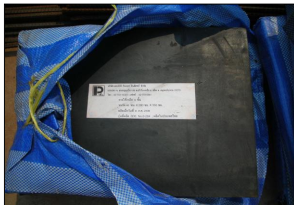
รูปที่ ๖-๓๗ ตรวจสอบแผ่นยางรอง I-Girder ตามข้อกำหนดในแบบก่อสร้าง
