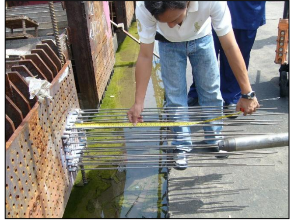
รูปที่ ๕-๑๒ ตรวจสอบระยะยึดของลวดอัดแรง
