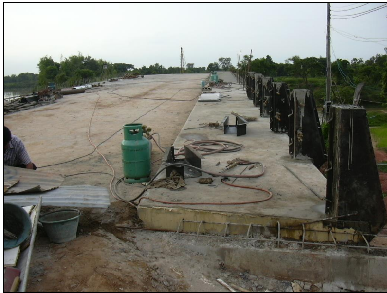
รูปที่ ๖-๕๖ การประกอบแบบและเทคอนกรีตเสาราวสะพาน
