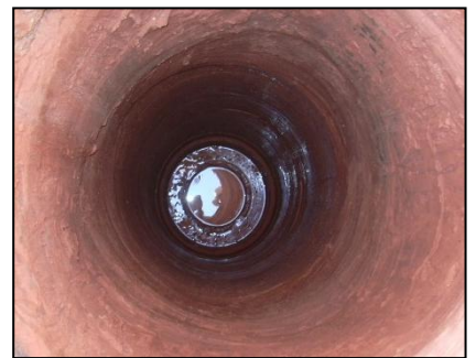
รูปที่ ๕-๔๐ หลุมที่เจาะผ่านชั้นหินทราย
