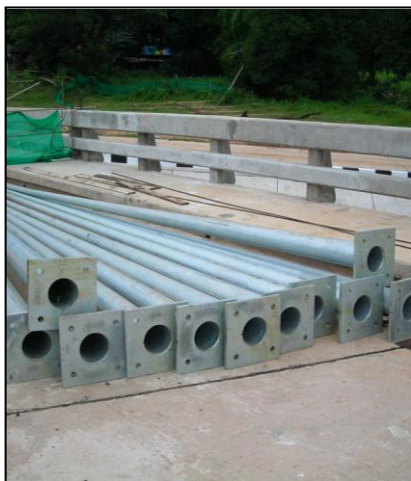
รูปที่ ๗-๑๘ เสาไฟฟ้าแสงสว่าง ก่อนการติดตั้ง
