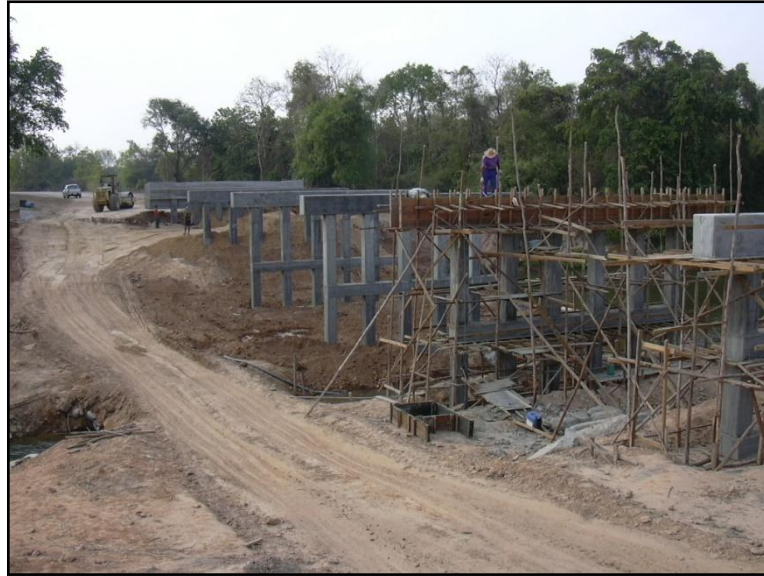
รูปที่ ๕-๕๔ การก่อสร้างเสาคอม่อสะพาน
