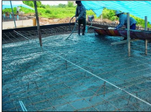
รูปที่ ๖-๒ เทคอนกรีตพื้นสะพานแบบหล่อในที่ (Slab Type)
