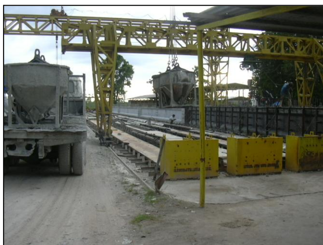
รูปที่ ๖-๕ ตรวจสอบแท่นรับแรง (Bed)
