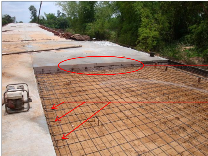
รูปที่ ๗-๙ การฝังเหล็กยึดรอยต่อตามยาว (Tie Bars)
