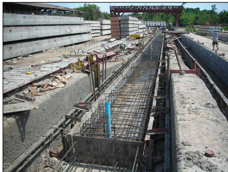
รูปที่ ๖-๘ ตรวจสอบเหล็กเสริมและความเรียบร้อยของแบบหล่อก่อนการเทคอนกรีตคานแบบแผ่นพื้น (Plank Girder)
