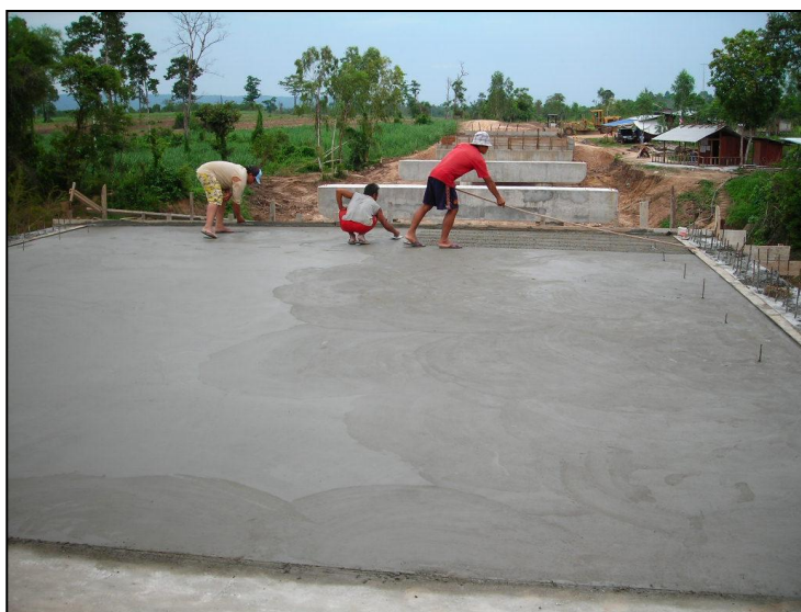
รูปที่ ๖-๑๙ การแต่งผิวหน้าคอนกรีตด้วยไม้กวาดลากผิวพื้น
