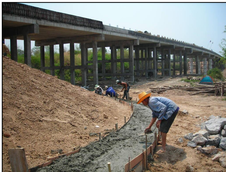
รูปที่ ๗-๒ งานเทคอนกรีตหล่อคานขอบ (Shear Key)
