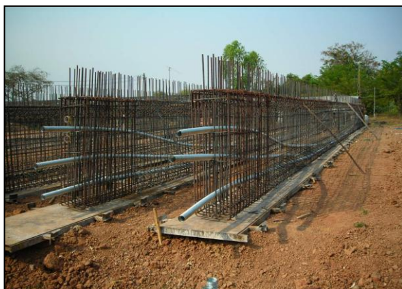
รูปที่ ๖-๓๙ ติดตั้งท่อร้อยลวดอัดแรงตามตำแหน่ง ที่ระบุในแบบก่อสร้าง
