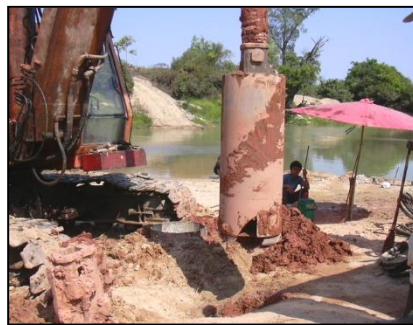
รูปที่ ๕-๓๙ ใช้ Bucket เก็บเศษหิน
