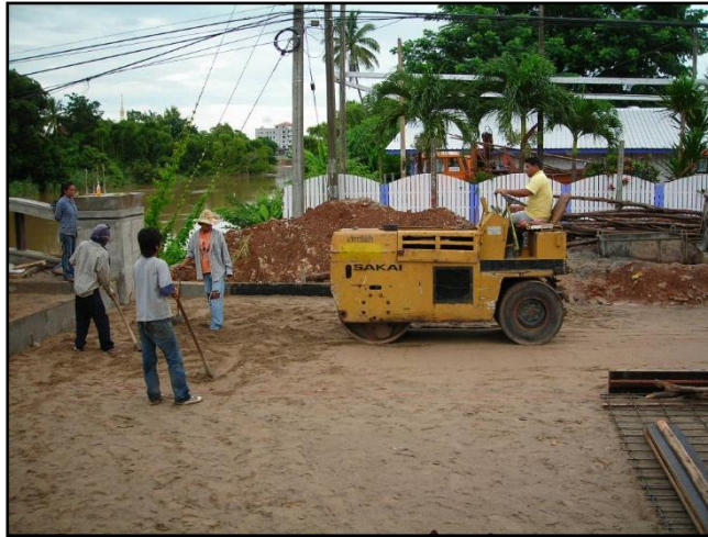
รูปที่ ๗-๗ การบดอัดทรายรองใต้พื้น Approach Slab
