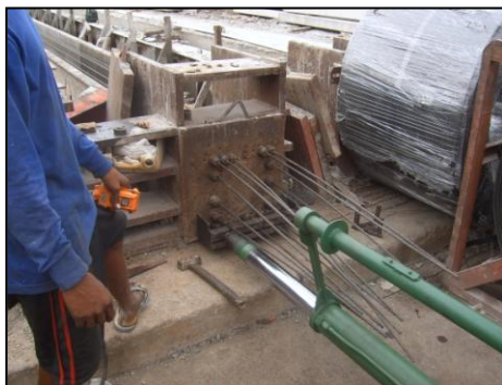
รูปที่ ๖-๑๑ การติดตั้งลวดอัดแรง
