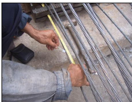
รูปที่ ๖-๑๓ การวัดค่าระยะยึดของลวด
