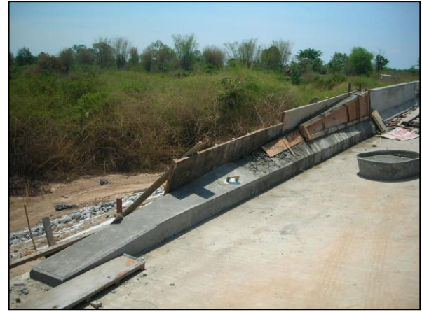
รูปที่ ๗-๑๖ เทคอนกรีตส่วนบนของราวกันตกคอนกรีตเป็นส่วนสุดท้าย
