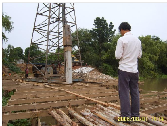
รูปที่ ๕-๑๙ การวัดขนาดลูกตุ้มเพื่อคำนวณหาน้ำหนัก
