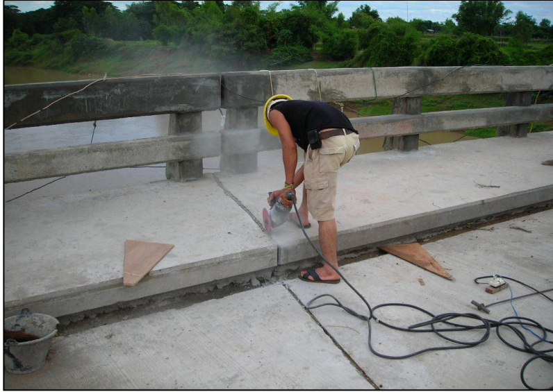
รูปที่ ๖-๕๕ การตัดแต่งรอยต่อและเจาะร่องรอยต่อระหว่างพื้นทางเท้าสะพาน
