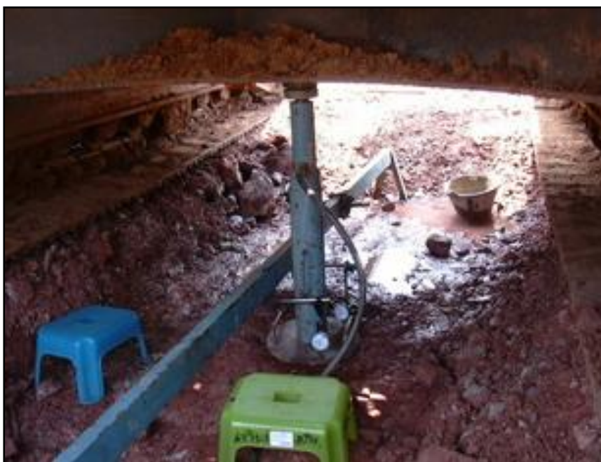
รูปที่ ๔-๑๓ การทดสอบกำลังรับน้ำหนักบรรทุกทุกปลอดภัยของดิน โดยวิธี Plate Bearing Test
