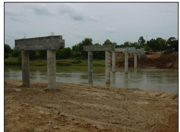
รูปที่ ๕-๖๐ ตอม่อสะพานช่วง ๓๐.๐๐ เมตร เมื่อก่อสร้างแล้วเสร็จ
