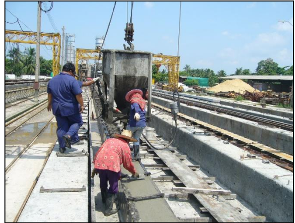
รูปที่ ๕-๑๔ การควบคุมการเทคอนกรีตเสาเข็ม
