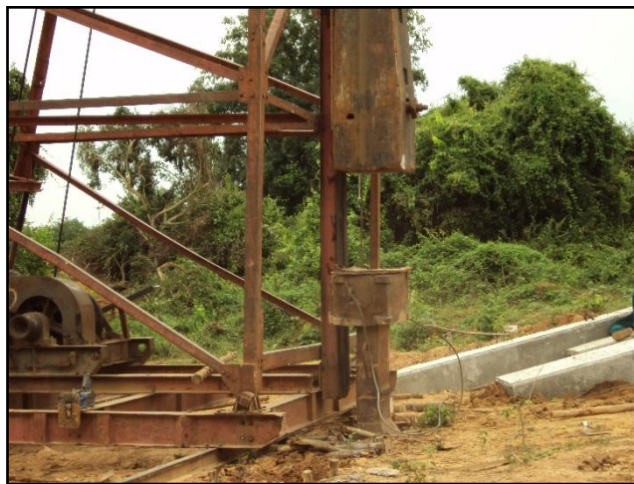
รูปที่ ๕-๒๗ การใช้เสาส่งตอกส่งเสาเข็มจนถึงระดับที่ต้องการ
