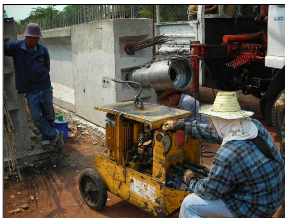
รูปที่ ๖-๔๒ ดึงลวดอัดแรงพร้อมกันทั้งกลุ่มตาม วิธีการและค่าแรงที่กำหนด
