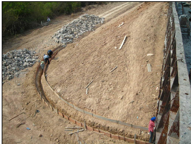
รูปที่ ๗-๑ งานดินถมรองรับดาดคอนกรีตป้องกันคอสะพาน และการเตรียมพื้นที่ก่อสร้างคานขอบ (Shear Key)
