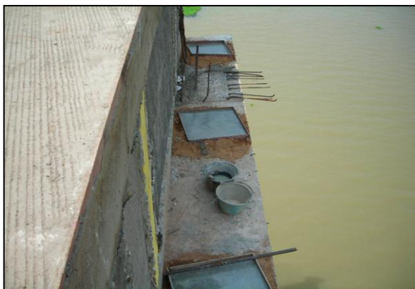
รูปที่ ๖-๓๖ ปรับระดับคานด้วย Non Shrinkage Motor
