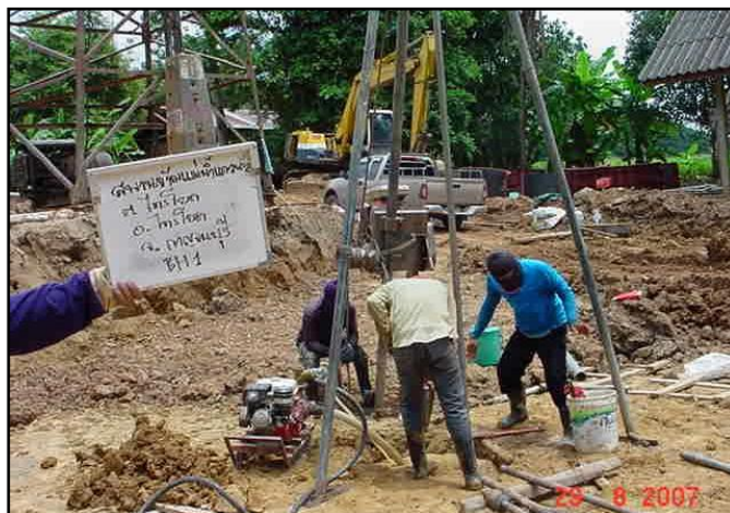
รูปที่ ๔-๑๒ การเจาะสำรวจชั้นดินโดยวิธี Standard Penetration Test (SPT)
