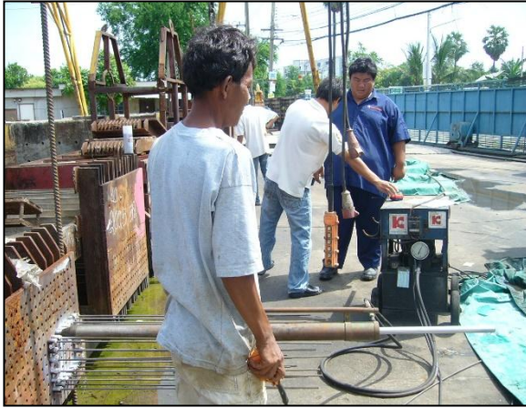
รูปที่ ๕-๑๑ การดัดลวดอัดแรง
