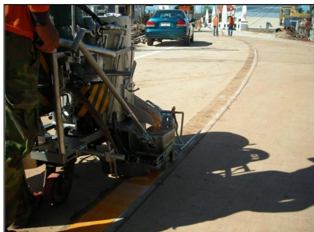
รูปที่ ๗-๒๒ ตีเส้นจราจรด้วยสีเทอร์โมพลาสติกและ โรยลูกแก้วสะท้อนแสง
