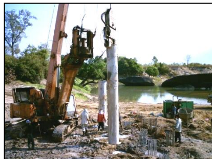
รูปที่ ๕-๓๕ ปักปลอกเหล็กชั่วคราว (Casing)
