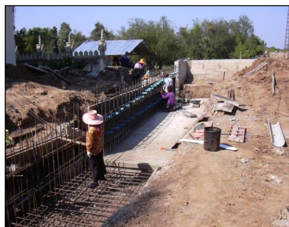
รูปที่ ๗-๑๔ ติดตั้งเหล็กเสริมและท่อระบายน้ำ
