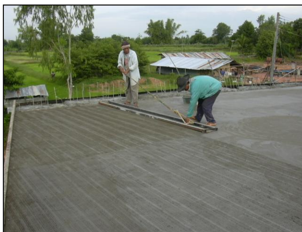
รูปที่ ๖-๔ การกริดผิวหน้าคอนกรีต
