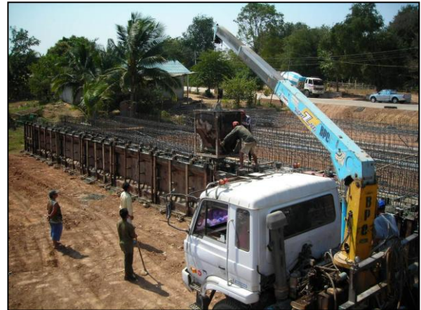
รูปที่ ๖-๔๑ เทคอนกรีตโดยให้เทให้เต็มตลอด ความยาวไล่ระดับขึ้นมาจนถึงหลังคาน
