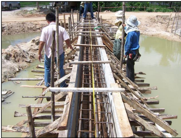
รูปที่ ๕-๕๘ การก่อสร้างคานหัวเสารับพื้นสะพาน (Cap Beam)
