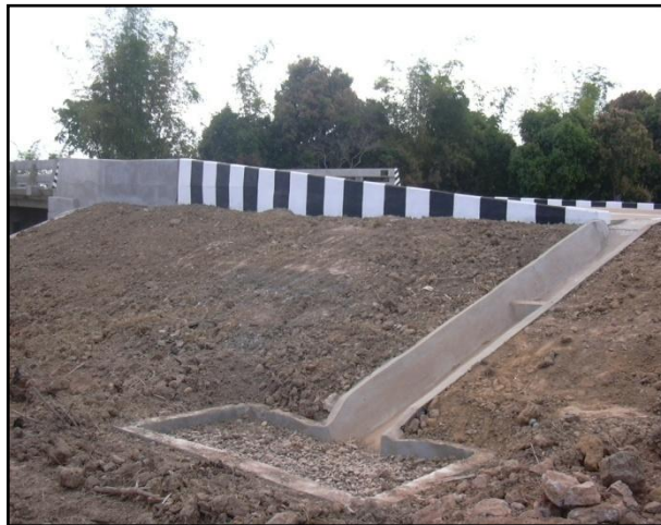
รูปที่ ๗-๑๒ รางระบายน้ำและบ่อพักบริเวณเชิงลาดคอสะพาน
