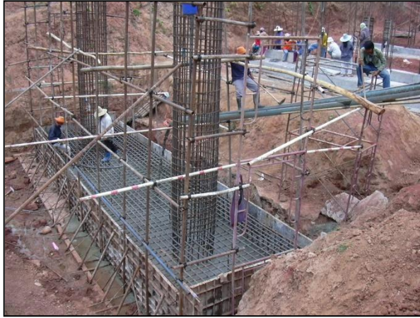
รูปที่ ๕-๕๖ ติดตั้งเหล็กเสริมเสาตอม่อ ในตำแหน่งที่ถูกต้อง
