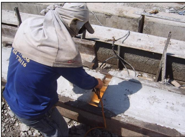
รูปที่ ๕-๑๕ การตัดลวดอัดแรงเสาเข็ม
