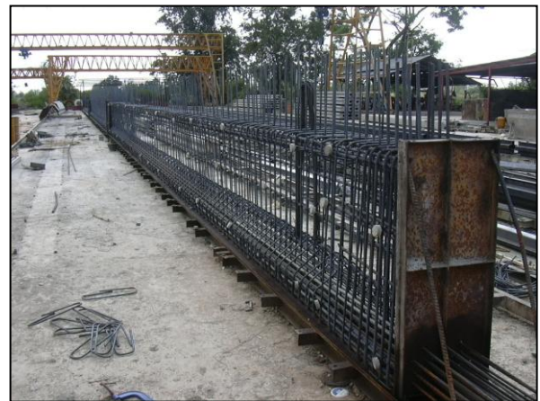
รูปที่ ๖-๓๔ ทำการ Debond ลวดอัดแรงตามตำแหน่งและระยะที่กำหนด
