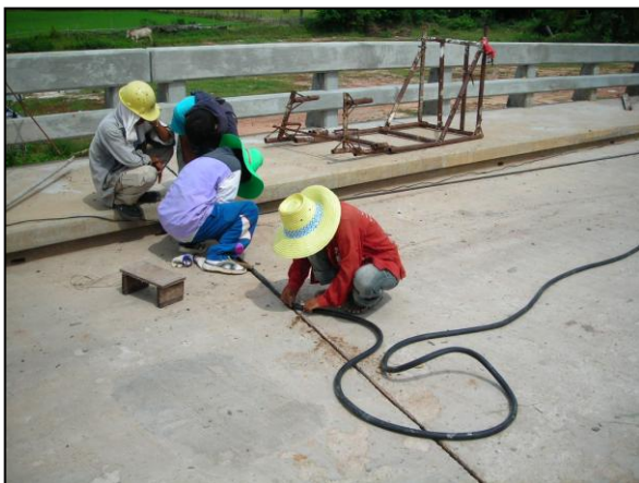
รูปที่ ๖-๕๐ ติดตั้งท่อยาง (Rubber Pipe For Joint) ที่รอยต่อพื้นสะพาน
