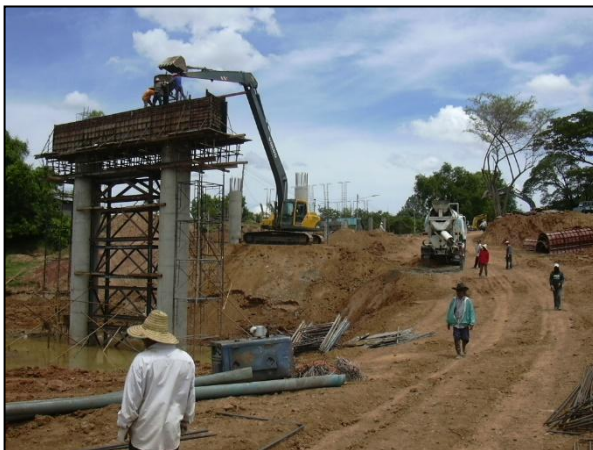
รูปที่ ๕-๕๙ เทคอนกรีตคานหัวเสารับพื้นสะพาน
