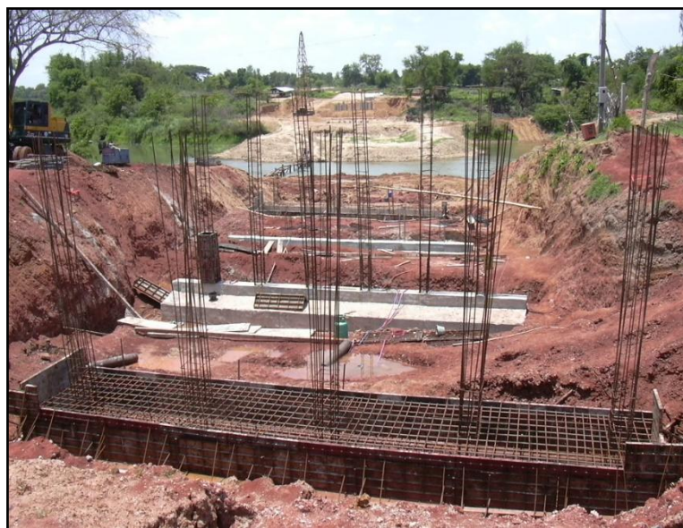
รูปที่ ๕-๕๓ การก่อสร้างฐานรากแผ่
