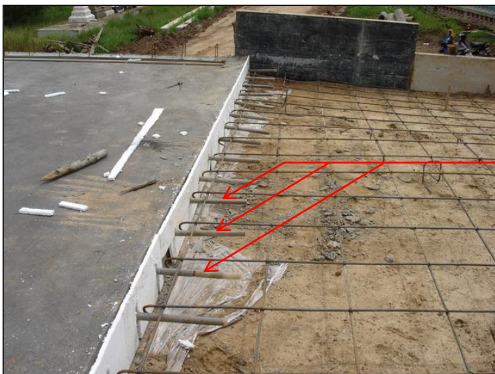
รูปที่ ๗-๑๐ การฝังเหล็กยึดรอยต่อตามขวาง (Dowel Bars)
