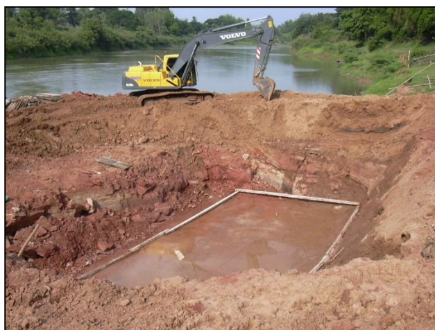
รูปที่ ๕-๕๒ ค้ำกันน้ำรอบพื้นที่ก่อสร้างฐานรากสะพานแบบฐานแผ่ (Cofferdam)
