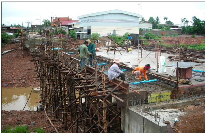
รูปที่ ๖-๕๓ การติดตั้งท่อระบายน้ำใต้ทางเท้าสะพาน
