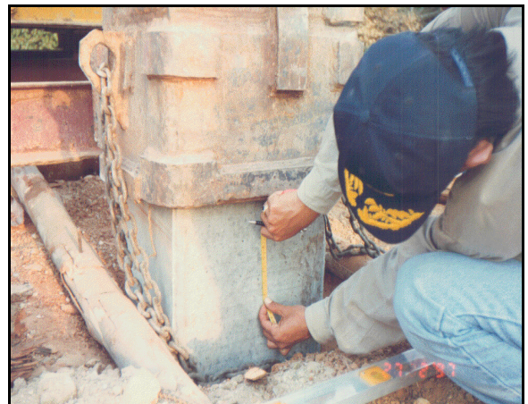
รูปที่ ๕-๒๔ การตอกเสาเข็มและการวัดระยะจมของเสาเข็มเมื่อตอก ๑๐ ครั้งสุดท้าย
