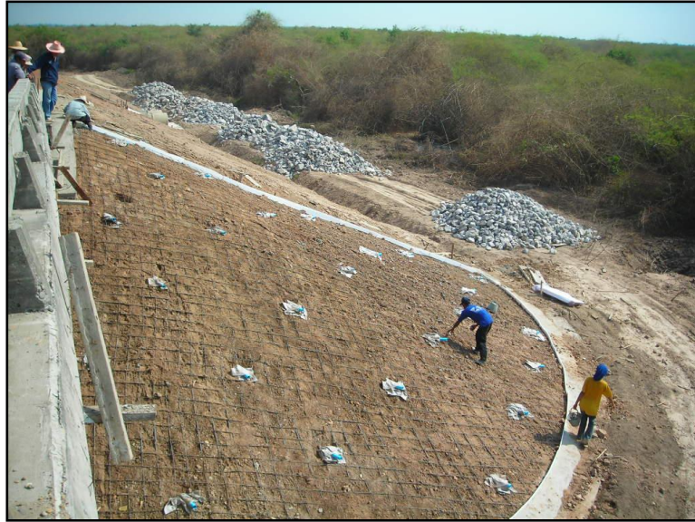
รูปที่ ๗-๓ งานติดตั้งท่อระบายน้ำและตะแกรงเหล็กเสริมลาดคอนกรีต
