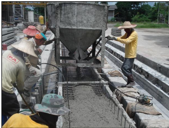
รูปที่ ๖-๒๖ เทคอนกรีต Box Girder
