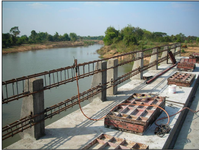
รูปที่ ๖-๕๗ การติดตั้งเหล็กเสริมราวสะพานบนเสาราวสะพาน
