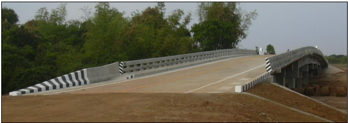
รูปที่ ๗-๑๗ ราวกันตกคอนกรีตฝั่งซ้ายและคันหินคอนกรีตฝั่งขวาบริเวณเชิงลาดคอสะพาน
