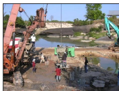
รูปที่ ๕-๔๕ เทคอนกรีตผ่าน Trimie Pipe
