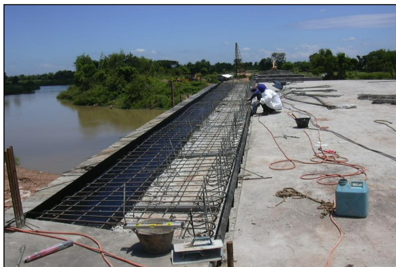
รูปที่ ๖-๕๒ การผูกเหล็กเสริมทางเท้าสะพาน
