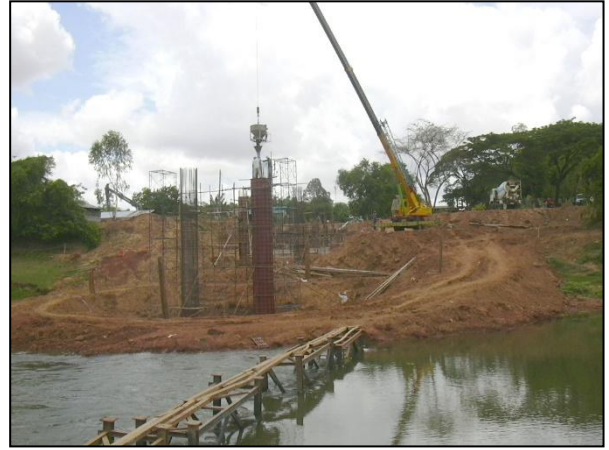
รูปที่ ๕-๕๗ เทคอนกรีตเสาตอม่อโดยใช้ท่อช่วย ส่งคอนกรีตลงสู่ด้านล่าง
