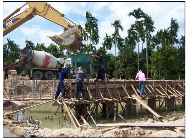
รูปที่ ๕-๕๘ การก่อสร้างคานหัวเสารับพื้นสะพาน (Cap Beam)
