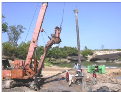
รูปที่ ๕-๔๒ ติดตั้ง Trimie Pipe
