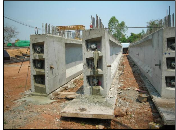
รูปที่ ๖-๔๕ อัดน้ำปูนในท่อน้ำลอดจนน้ำปูนล้นออกที่ปลายคาน่อีกด้าน
