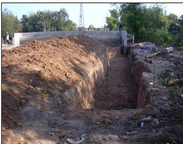
รูปที่ ๗-๑๓ บดอัดดินเดิมให้ได้ความแน่นก่อน ก่อสร้างฐานกำแพงกันดิน
