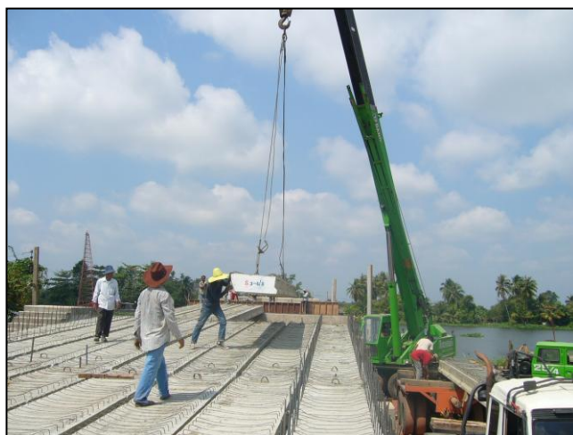
รูปที่ ๖-๑๕ การติดตั้งคานคอนกรีตอัดแรงแบบแผ่นพื้น (Plank Girder)
