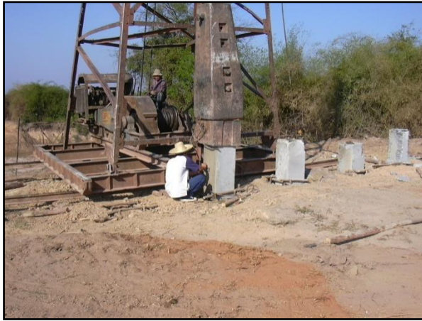
รูปที่ ๕-๒๔ การตอกเสาเข็มและการวัดระยะจมของเสาเข็มเมื่อตอก ๑๐ ครั้งสุดท้าย
