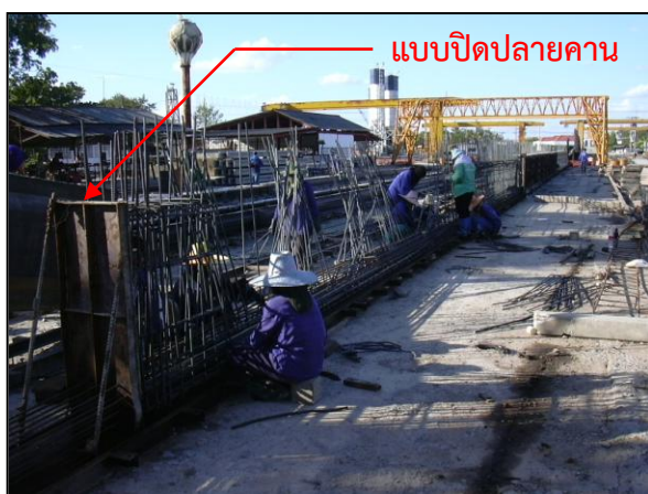
รูปที่ ๖-๓๕ ตรวจสอบแบบหัวคานว่าวางเรียงตามความลาดชันและมีค่ามุม Skew ถูกต้อง
