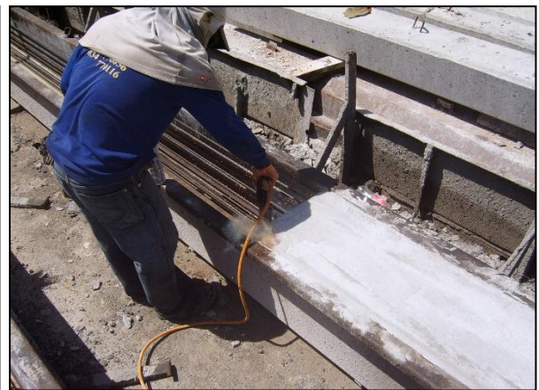
รูปที่ ๕-๑๕ การตัดลวดอัดแรงเสาเข็ม
