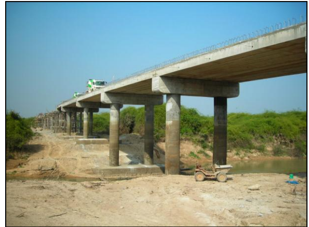
รูปที่ ๖-๓๑ Box Girder (ช่วง ๒๐.๐๐ เมตร) ที่ติดตั้งแล้วเสร็จ
