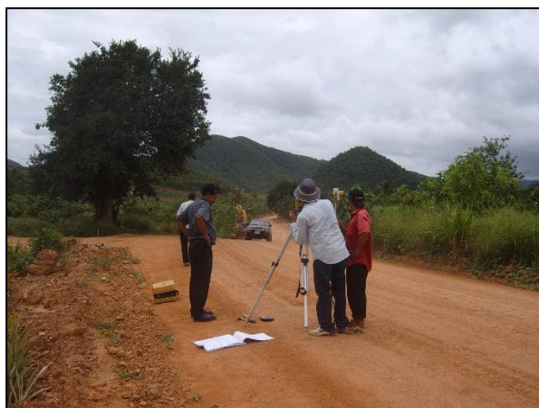
รูปที่ ๔-๒ การตรวจสอบแนวและตรวจพื้นที่ก่อสร้าง
