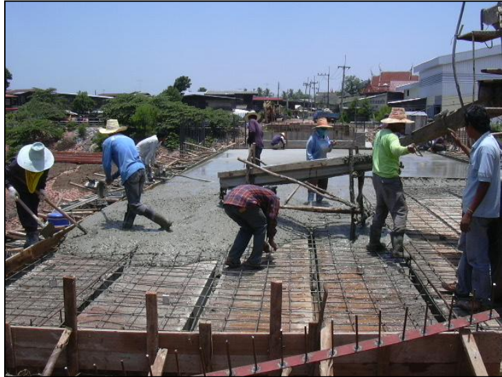
รูปที่ ๖-๑๘ การเทคอนกรีตทับหน้าพื้นสะพาน (Concrete Topping)
