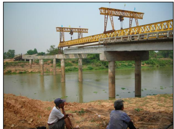
รูปที่ ๖-๔๗ ติดตั้ง I-Girder ด้วยวิธี Launching
