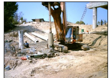
รูปที่ ๕-๓๗ ปล่อยทรายทิ้งที่ปากหลุม
