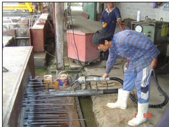
รูปที่ ๖-๒๓ ตรวจสอบและควบคุมการผลิตคานที่โรงงาน
