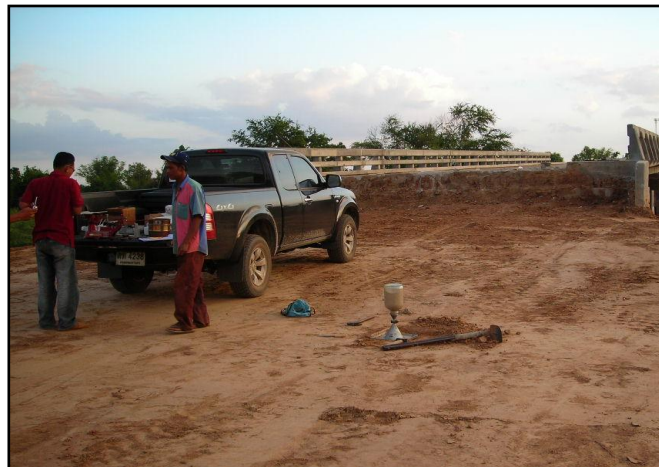
รูปที่ ๗-๕ การทดสอบความแน่นชั้นโครงสร้างทางที่รองรับ Approach Slab โดยการทำ Sand Cone Test
