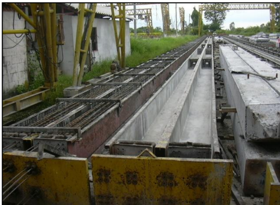
รูปที่ ๕-๘ แท่นผลิตเสาเข็ม (Yard)
