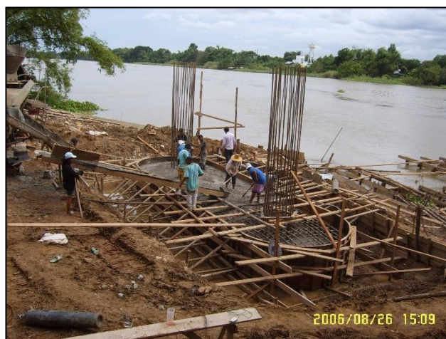
รูปที่ ๕-๕๒ ค้ำกันน้ำรอบพื้นที่ก่อสร้างฐานรากสะพานแบบฐานแผ่ (Cofferdam)
