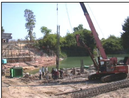
รูปที่ ๕-๔๑ ติดตั้งเหล็กเสริม
