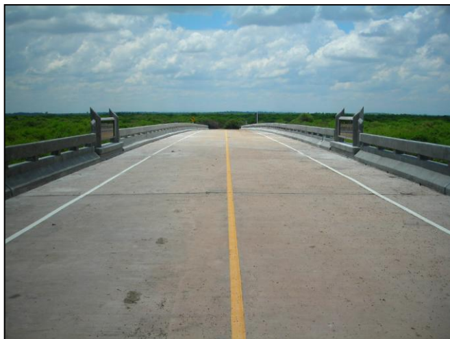
รูปที่ ๖-๓๒ พื้นสะพานหลังจากเทคอนกรีตพื้นสะพานแล้วเสร็จ
