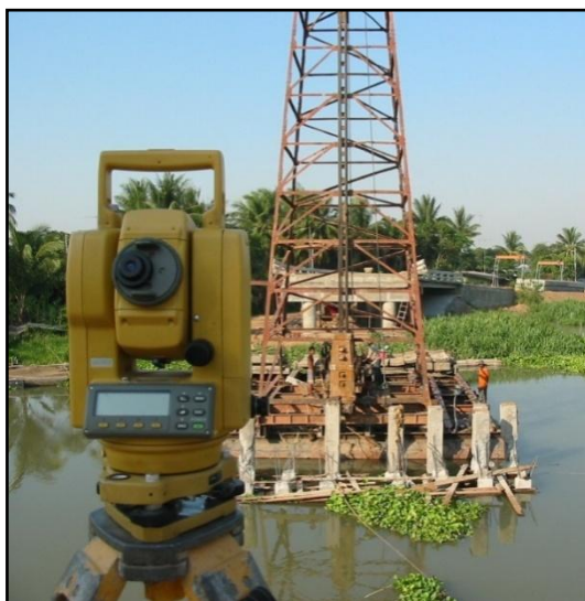
รูปที่ ๕-๒๒ การตรวจสอบแนวตั้งของเสาเข็มขณะตอก
