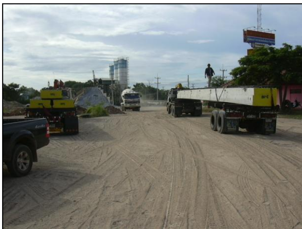
รูปที่ ๖-๒๘ การขนส่ง Box Girder จากโรงงานผลิตสู่สถานที่ก่อสร้าง
