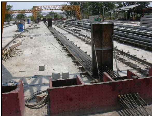
รูปที่ ๖-๓๓ ร้อยลวดอัดแรง I-Girder
