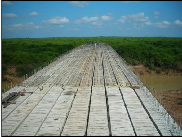
รูปที่ ๖-๓๐ Box Girder (ช่วง ๒๐.๐๐ เมตร) ที่ติดตั้งแล้วเสร็จ ก่อนเทคอนกรีตทับหน้า
