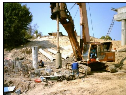
รูปที่ ๕-๓๖ ใช้ Bucket เจาะชั้นทราย
