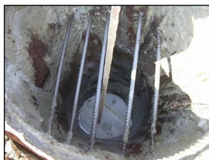
รูปที่ ๕-๔๔ ปิด Plug โฟม ด้วยแผ่นสังกะสี
