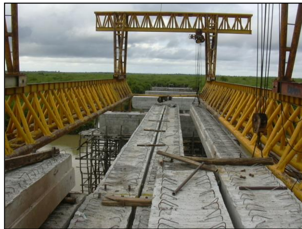
รูปที่ ๖-๒๙ การติดตั้ง Box Girder ด้วยวิธี Launching
