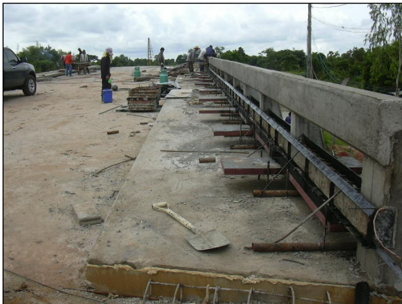
รูปที่ ๖-๕๘ การประกอบแบบและเทคอนกรีตราวสะพาน
