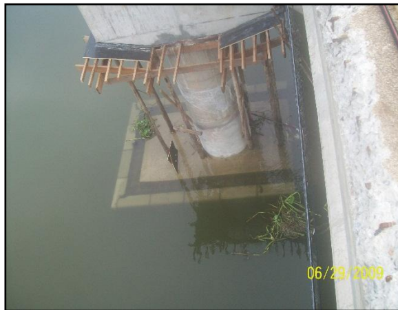
รูปที่ ๗-๑๑ การบ่มคอนกรีต (กระสอบคลุม พ่นน้ำยา และคลุมพลาสติก)
