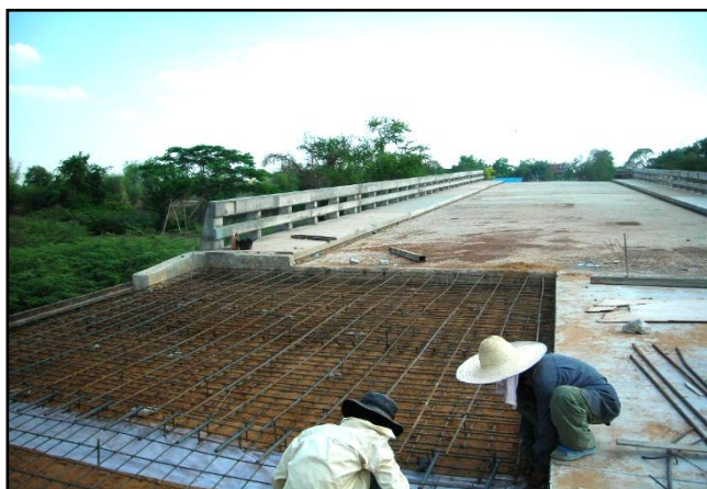
รูปที่ ๗-๘ เหล็กเสริม Approach Slab และการปูแผ่นพลาสติกใต้รอยต่อแผ่นพื้นคอนกรีต
