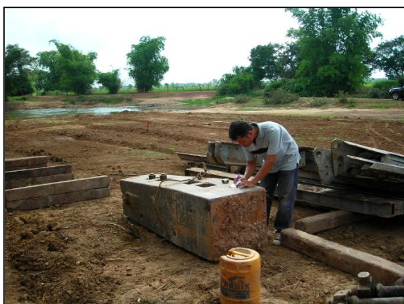
รูปที่ ๕-๑๙ การวัดขนาดลูกตุ้มเพื่อคำนวณหาน้ำหนัก
