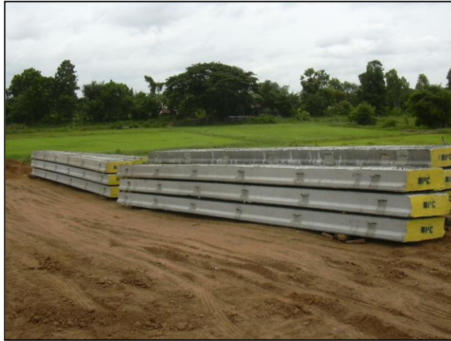
รูปที่ ๖-๑๔ การเก็บกองคานคอนกรีตอัดแรงแบบแผ่นพื้น (Plank Girder)
