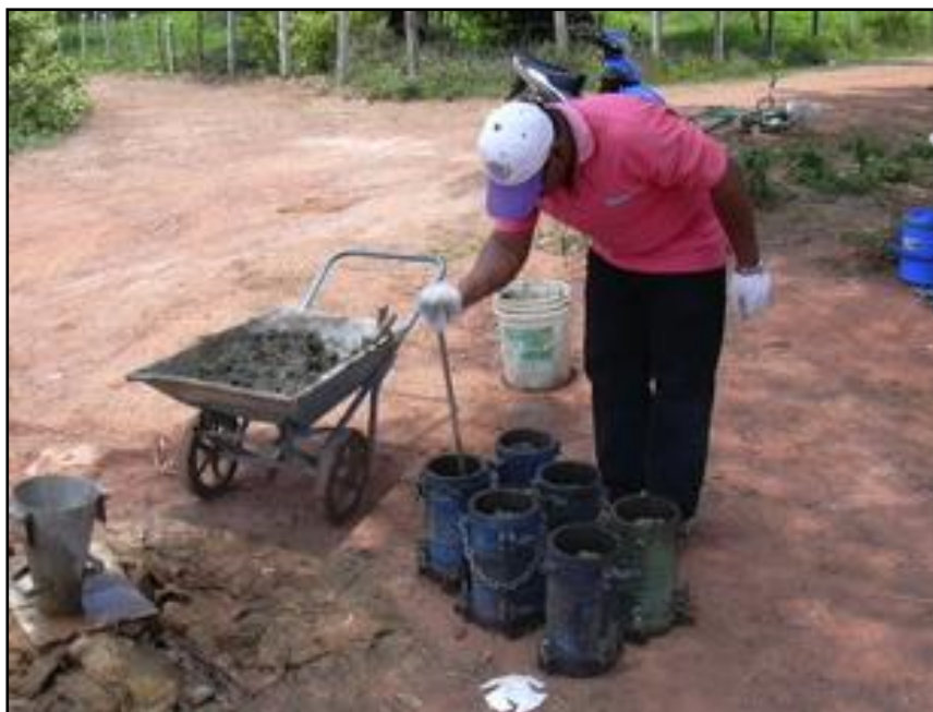
รูปที่ ๔-๑๐ การเก็บตัวอย่างคอนกรีตรูปทรงกระบอก ขนาดเส้นผ่านศูนย์กลาง ๑๕ x ๓๐ เซนติเมตร
