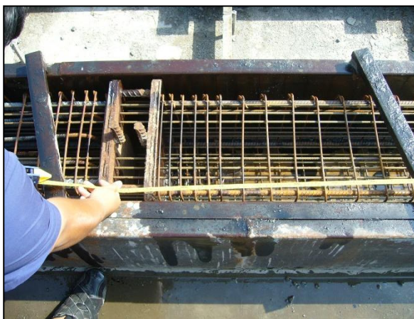
รูปที่ ๕-๑๓ ตรวจสอบเหล็กเสริมและระยะหุ้มคอนกรีตก่อนทำการเทคอนกรีตเสาเข็ม
