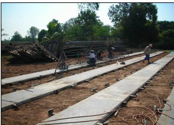
รูปที่ ๖-๓๘ เตรียมพื้นที่ก่อสร้างให้ได้ระดับและ สะดวกต่อการทำงาน
