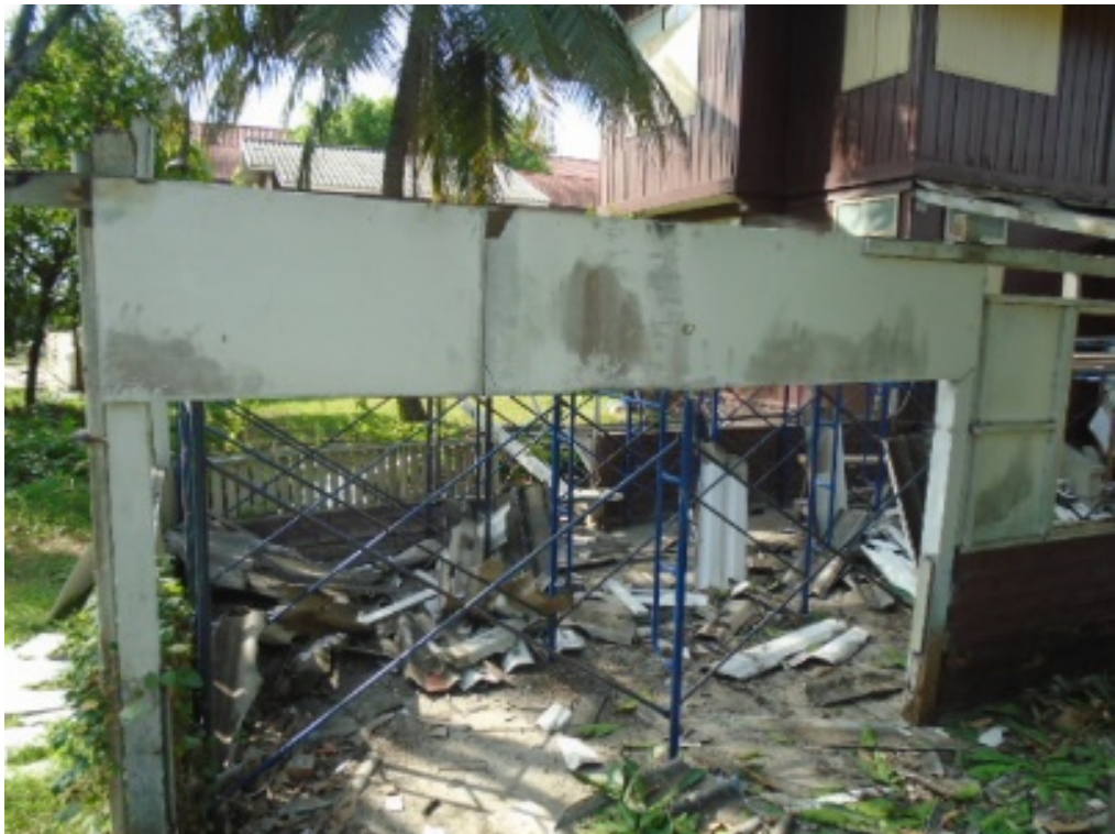
ภาพที่ ๓๑ บ้านพักระหว่างดำเนินการปรับปรุงซ่อมแซม
