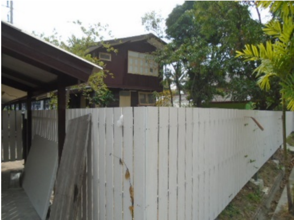
ภาพที่ ๓๒ บ้านพักหลังดำเนินการปรับปรุงซ่อมแซมแล้วเสร็จ
