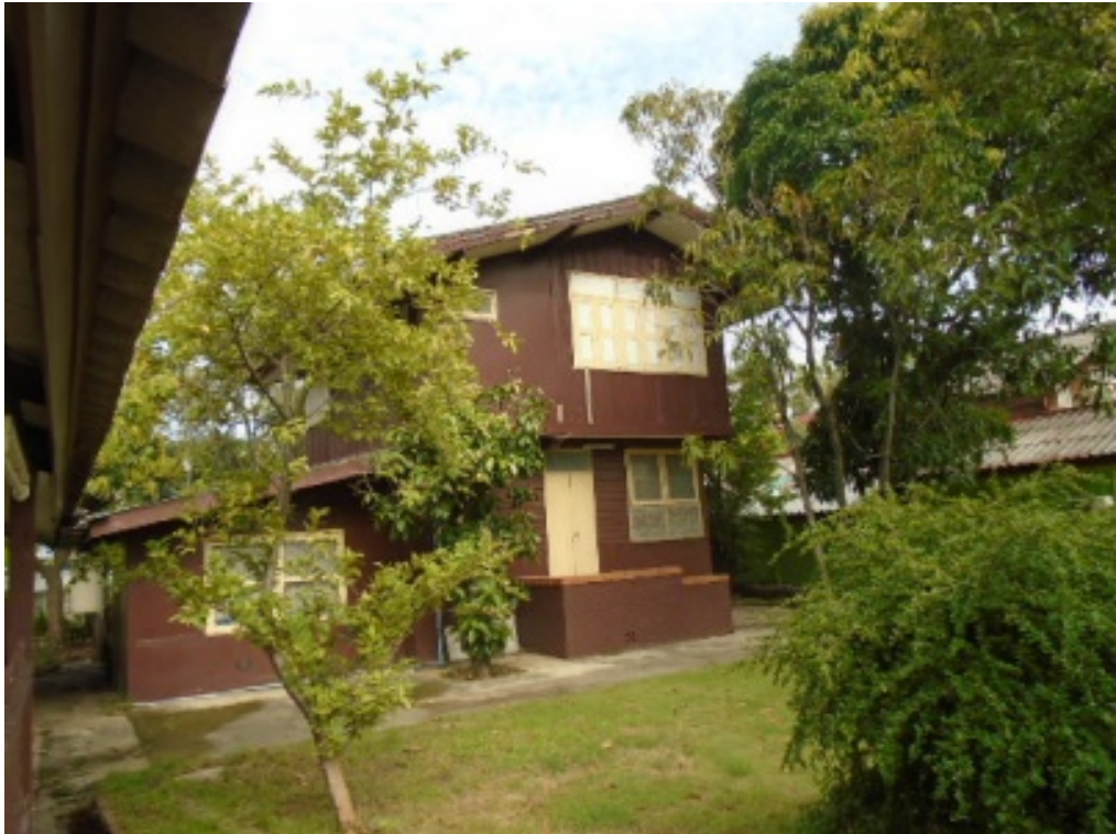
ภาพที่ ๒๖ บ้านพักก่อนดำเนินการปรับปรุงซ่อมแซม
