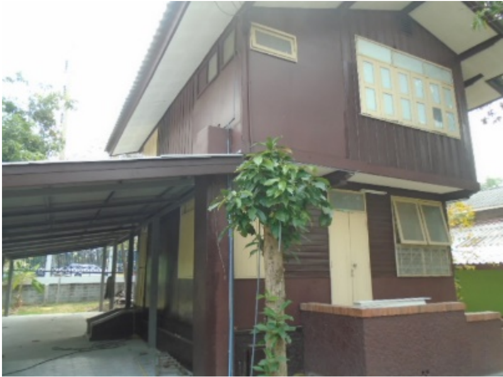
ภาพที่ ๓๔ บ้านพักหลังดำเนินการปรับปรุงซ่อมแซมแล้วเสร็จ
