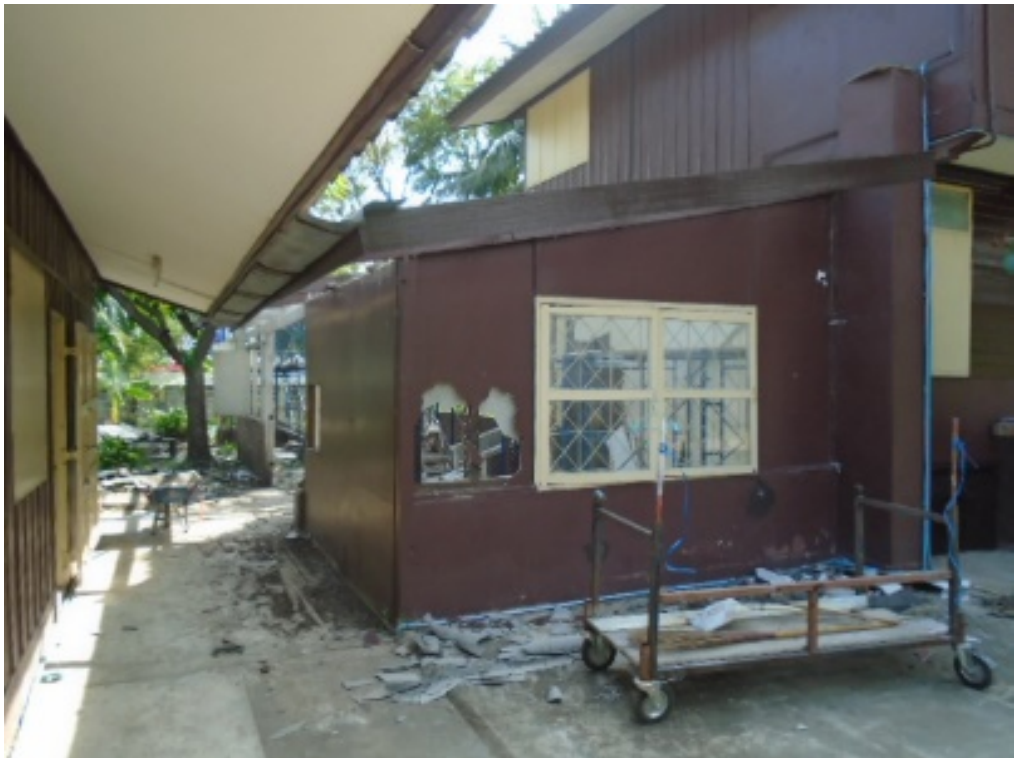
ภาพที่ ๒๙ บ้านพักระหว่างดำเนินการปรับปรุงซ่อมแซม
