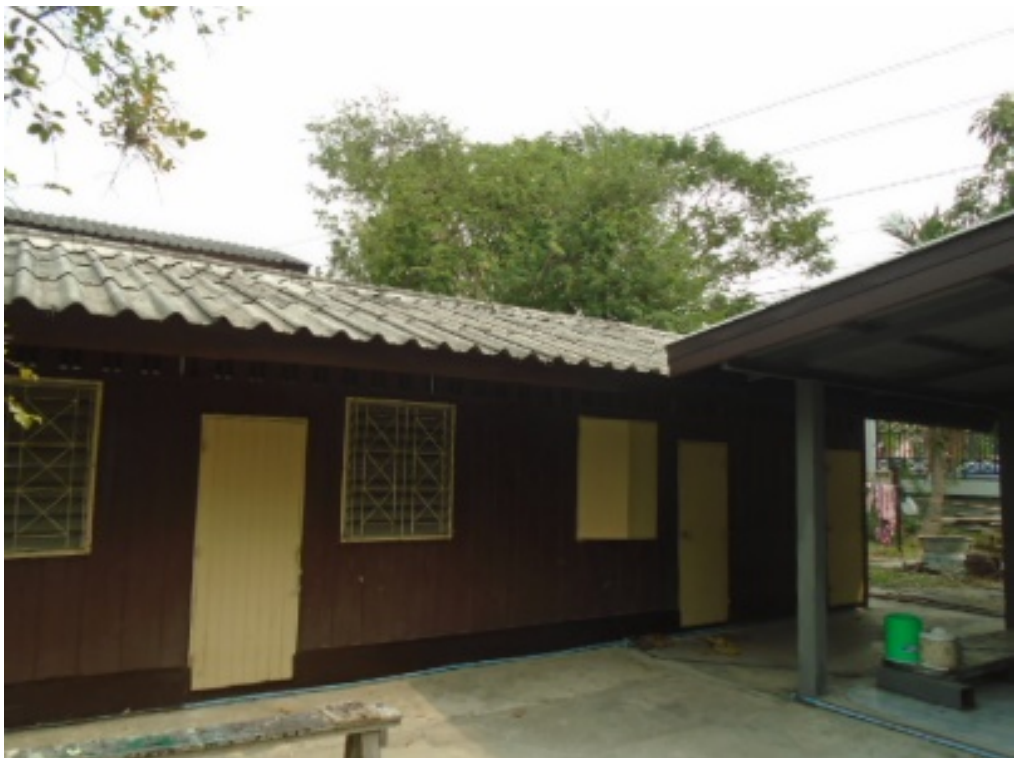
ภาพที่ ๓๓ บ้านพักหลังดำเนินการปรับปรุงซ่อมแซมแล้วเสร็จ
