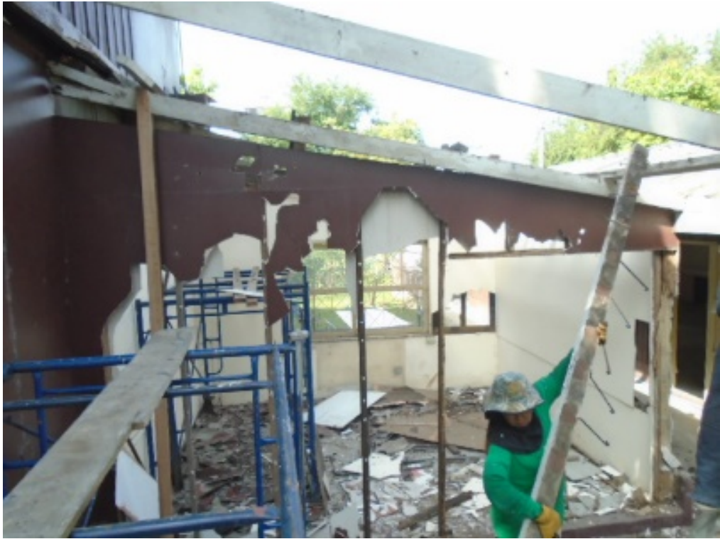
ภาพที่ ๓๐ บ้านพักระหว่างดำเนินการปรับปรุงซ่อมแซม
