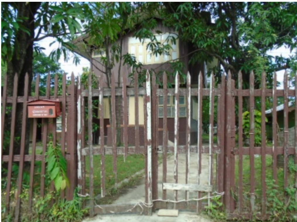
ภาพที่ ๒๗ บ้านพักก่อนดำเนินการปรับปรุงซ่อมแซม
