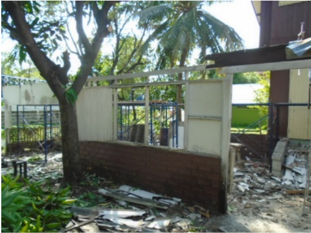
ภาพที่ ๒๘ บ้านพักระหว่างดำเนินการปรับปรุงซ่อมแซม
