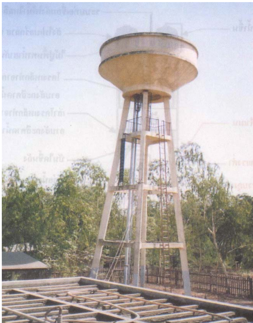
รูปที่ 11 ถังคอนกรีตเสริมเหล็ก
