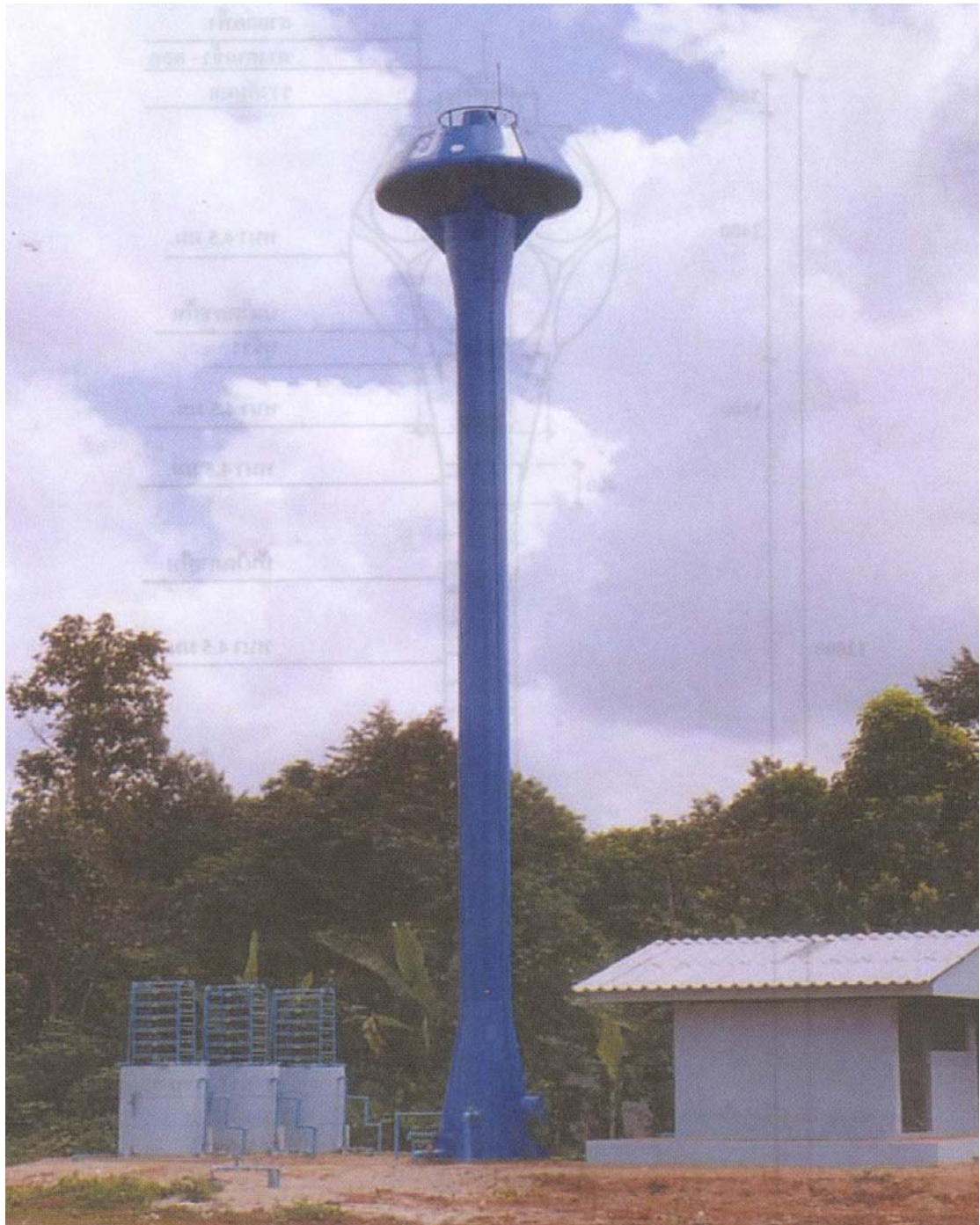
รูปที่ 9 หอถังเหล็กรูปทรงแชมเปญ
