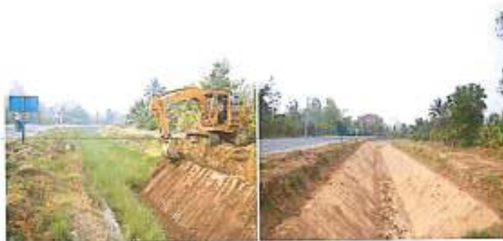
ลักษณะการใช้รถขุดไฮดรอลิกชนิดดินตะขាប់งัดที่ดักเข้า [HB-CM] กับงานขุดลอกคลองส่งน้ำ
