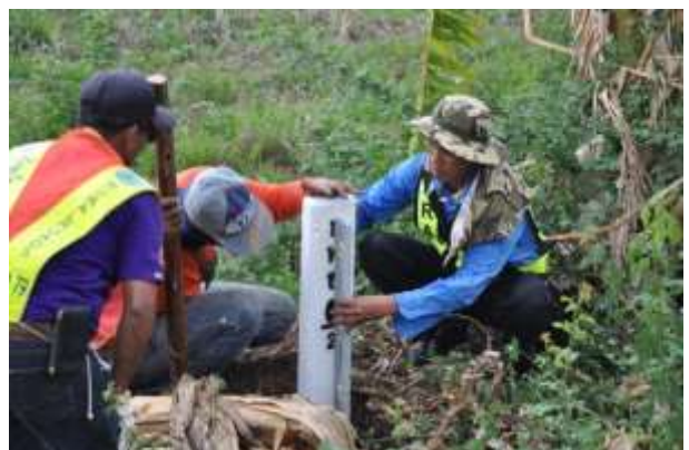
รูปที่ 3-55 เมื่อตรวจสอบแล้วหลักเขตทางหลวงชนบทชำรุด หรือสูญหายให้ทดแทนหลักเขตทางหลวงชนบทในตำแหน่งที่ถูกต้อง
