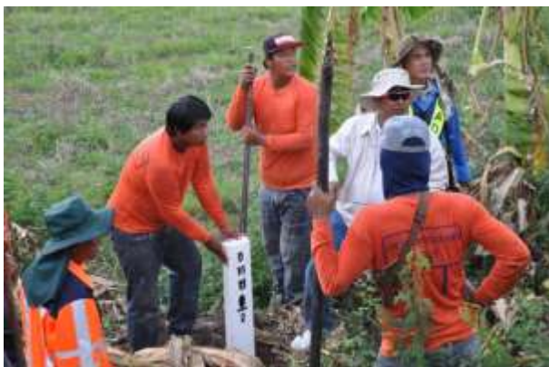
รูปที่ 3-55 เมื่อตรวจสอบแล้วหลักเขตทางหลวงชนบทชำรุด หรือสูญหายให้ทดแทนหลักเขตทางหลวงชนบทในตำแหน่งที่ถูกต้อง
