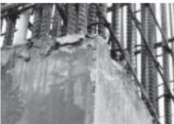
รูปที่ 11-10 ผลของการใส่สารหน่วงการก่อตัวในคอนกรีตเกินปริมาณที่กำหนด ทำให้คอนกรีตมีเนื้อนุ่มและไม่แข็งตัว
