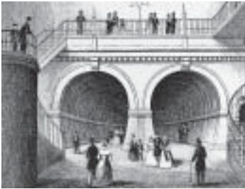
รูปที่ 1-8 อุโมงค์คอนกรีตลอดแม่น้ำ เทมส์ 6
