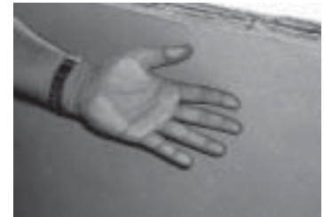
รูปที่ 7-26 ผิวผนังเป็นฝุ่น
