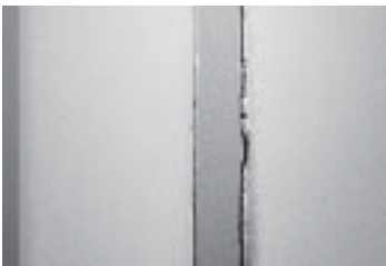
รูปที่ 6-16 ผนังแตกร้าวบริเวณขอบเสาในแนวตั้ง เนื่องจากการไม่ได้เสียบหรือเสียบเหล็กหนวดกุ้งไม่ถูกวิธี หรือไม่ได้ทำเสาเอ็น
