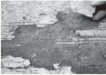
รูปที่ 12-14 ผิวหน้าคอนกรีตเกิดเป็นชั้นบาง ๆ ที่เรียกว่า Laitance ทำให้หลุดลอกเป็นแผ่น ๆ ซึ่งมีสาเหตุมาจากการแต่งผิวหน้าคอนกรีตในขณะที่ยังมีน้ำเยิ้มอยู่
