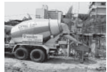
ก) คายคอนกรีตจากรถโมโตไซด์ถึงถังเหล็ก
