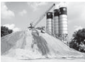
รูปที่ 17-15 คอนกรีตผสมเสร็จ มีการกองเก็บหิน ทราย และปูนซีเมนต์ไว้ที่โรงงาน จึงช่วยแก้ปัญหาทางานก่อสร้างที่มีบริเวณก่อสร้างจำกัดได้
