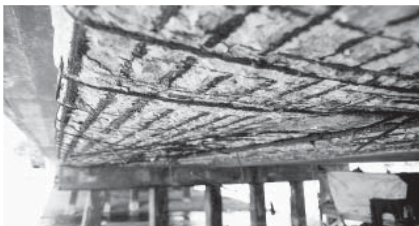
รูปที่ 10-4 พื้นสะพานคอนกรีตเสริมเหล็กที่ตั้งอยู่ใกล้ทะเล ได้รับความเสียหายอย่างรุนแรง เนื่องจากการกระทำของคลอไรด์
