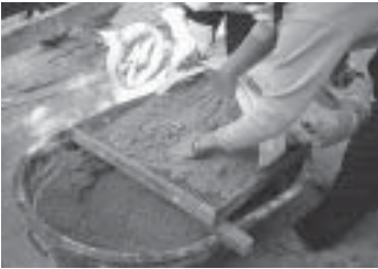
รูปที่ 7-6 การร่อนทราย เพื่อคัดเอาวัสดุปลอมปนออกก่อนนำไปใช้งาน
