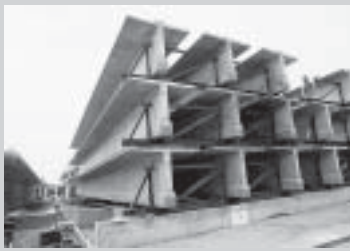
จ) คานสะพานคอนกรีตอัดแรงสำเร็จรูป
