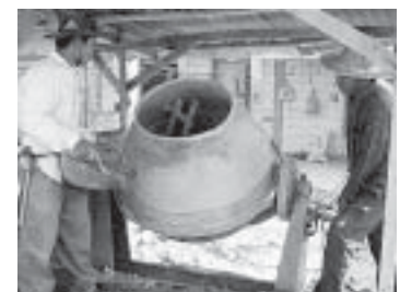
รูปที่ 13-10 การผสมคอนกรีตด้วยไม้ขนาดเล็ก
