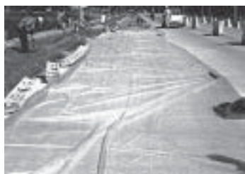
ก) การใช้สารเคลือบผิวคอนกรีตหรือน้ำยา ข) การใช้แผ่นพลาสติกคลุมบ่มคอนกรีต
