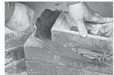
รูปที่ 4-21 Slag Cement สามารถนำมาใช้ในงานก่ออิฐฉาบผิวได้
