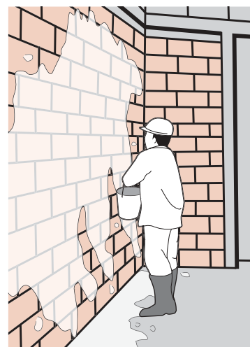
รูปที่ 6-20 เมื่อผิวปูนก่อแห้งแล้ว ควรทำการบ่มอย่างน้อย 7 วัน
