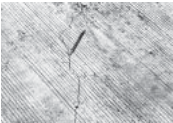
รูปที่ 14-2 การขาดการบ่มคอนกรีต หรือการบ่มล่าช้าเกินไป หรือการบ่มอย่าง ผิดวิธี เป็นสาเหตุหลักของการแตกร้าว (Plastic Shrinkage Crack) ของพื้น คอนกรีตในขณะที่กำลังแข็งตัวในสภาพ อากาศร้อนหรือมีลมพัดแรง
