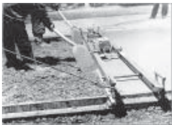
ข ) Vibrating Screed ชนิดคานคู่
