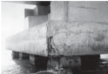
ก) ตัวอย่างความเสียหายของโครงสร้างในน้ำทะเล
