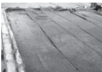
ค) การใช้วัสดุเปียกขึ้นคลุม
