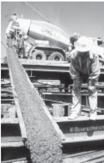
รูปที่ 13-24 การเทคอนกรีตให้ใกล้จุดที่ต้องการจะเทมากที่สุดแบบหล่อเพื่อป้องกันการแยกตัว
