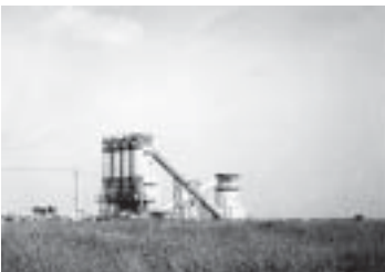
รูปที่ 8-17 โรงงานคอนกรีตผสมเสร็จแบบแนวตั้ง มีการเก็บวัตถุดิบไว้ในไซโล จึงช่วยป้องกันปัญหาฝุ่นละอองในอากาศ ถือเป็นอีกหนึ่งเทคโนโลยีที่มีความเป็นมิตรกับสิ่งแวดล้อม
