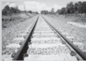
ฉ) ท่อนรางรถไฟคอนกรีตอัดแรงสำเร็จรูป
