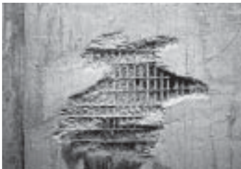
รูปที่ 13-39 ผิวคอนกรีตเป็นรูพรอง (Honeycomb)
