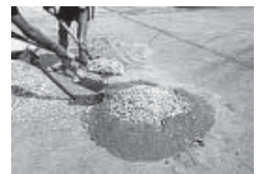
รูปที่ 13-9 การผสมคอนกรีตด้วยมือ
