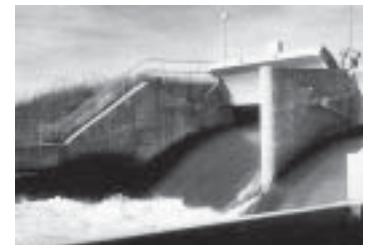
รูปที่ 4-12 ปูนซีเมนต์ปอร์ตแลนด์ ประเภทเกิดความร้อนต่ำ เหมาะสำหรับงานคอนกรีตมวล เช่น เขื่อน เป็นต้น
