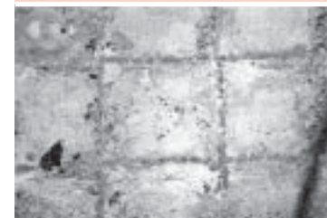
รูปที่ 12-17 ลักษณะรอยแตกร้าวเนื่องจากการทรุดตัวในขณะกำลังก่อตัว (Plastic Settlement Crack)
