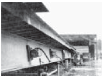
รูปที่ 13-42 โต๊ะเขย่าคอนกรีต 9
