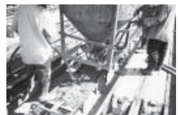
รูปที่ 13-23 การเทและการอัดแน่นคอนกรีต เป็นขั้นตอนการทำคอนกรีตที่ดำเนินไปพร้อม ๆ กัน
