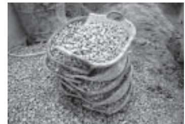
รูปที่ 13-5 งานก่อสร้างขนาดเล็ก มักนิยมใช้การตวงปริมาตรมวลรวมด้วยปั้งที่ ซึ่งเป็นวิธีการวัดที่มีความไม่แน่นอนสูง ทำให้มักได้คอนกรีตที่มีกำลังอัดต่ำ และมีคุณภาพไม่สม่ำเสมอ
