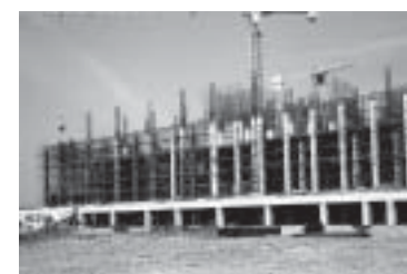
ข) ใช้ทาวเวอร์เครนยกถังเหล็กในการลำเลียงคอนกรีตไปเทยังอาคารชั้นบน ๆ
