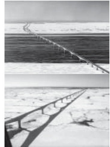
รูปที่ 4-16 ปูนซีเมนต์ปอร์ตแลนด์ประเภทที่ 4-16 ปูนซีเมนต์ปอร์ตแลนด์ประเภทที่กระจายกักฟองอากาศ เหมาะสำหรับงานโครงสร้างในสภาพภูมิอากาศหนาวเย็น เช่น สะพานข้ามทะเลที่มีแผ่นน้ำแข็งไหลผ่าน 8
