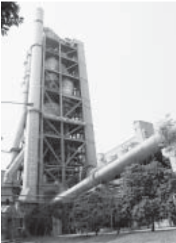
รูปที่ 2-15 Preheater
