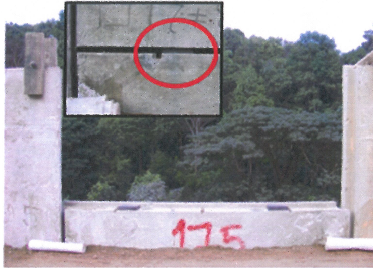
รูปที่ ๒.๙ การติดตั้งแผ่นยางรอง (Rubber Pads)
