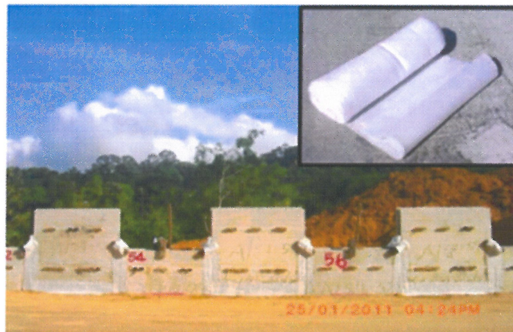
รูปที่ ๒.๖ การติดตั้งแผ่นปิดระหว่างรอยต่อ (Geotextile)
