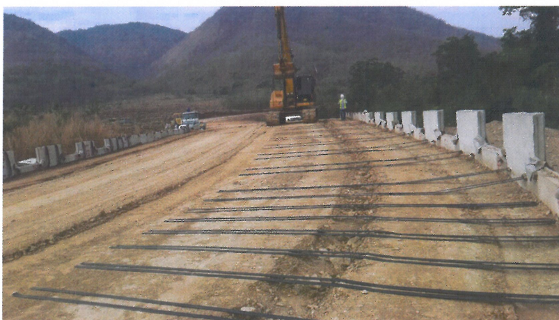
รูปที่ ๔.๑.๗ การขุดร่อง (Trench)
