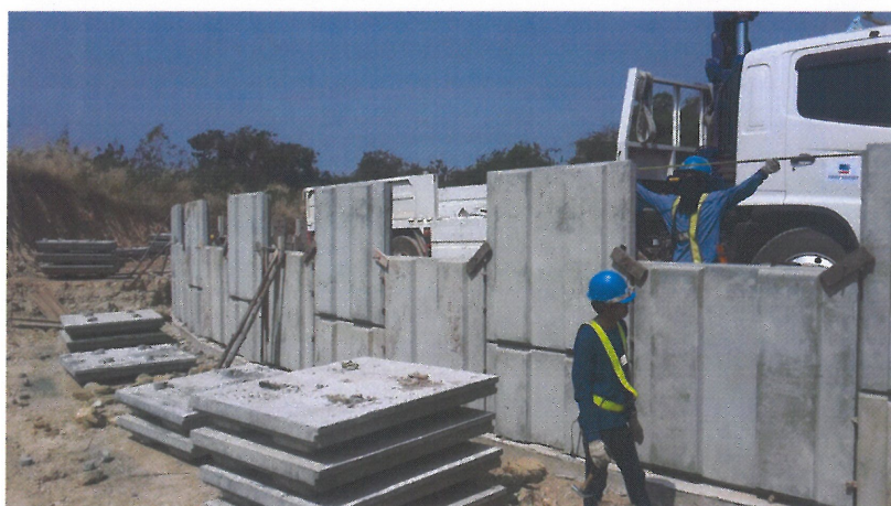
รูปที่ ๔.๒.๒ การวางแผ่นคอนกรีตแถวถัดไป
