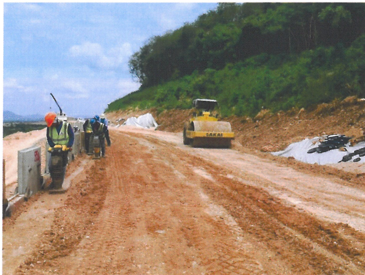
รูปที่ ๒.๑๐ การลำเรียงวัสดุดินถมเสริมกำลัง (Select granular backfill)
