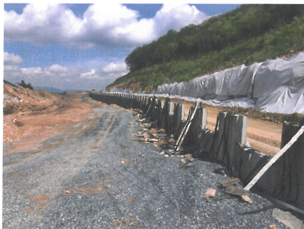
รูปที่ ๔.๑.๒ การติดตั้งแผ่นคอนกรีตแถวแรก
