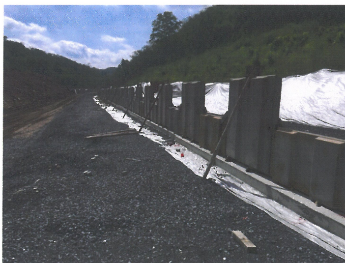
รูปที่ ๔.๑.๔ การค้ำยันแผ่นคอนกรีต
