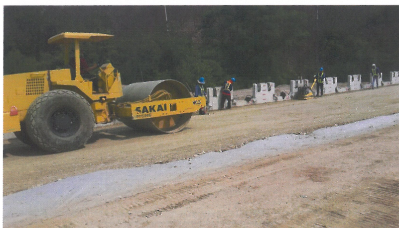
รูปที่ ๔.๑.๖ การถมและบดอัดวัสดุดินถมเสริมกำลัง (Select granular backfill)
