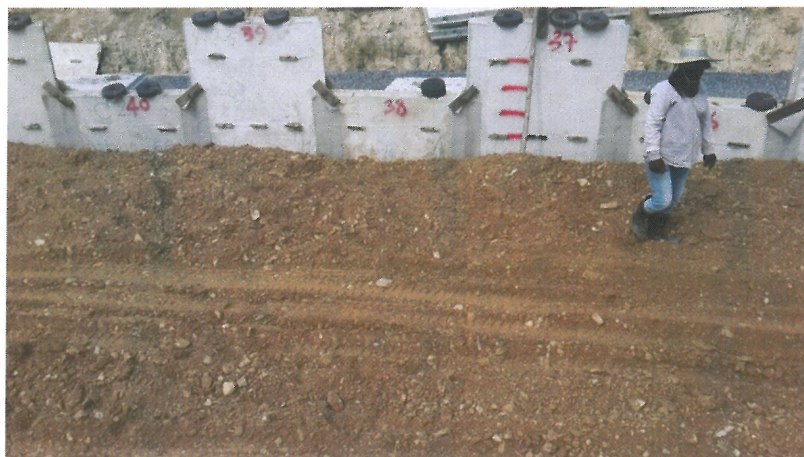
รูปที่ ๔.๑.๕ การปิดรอยต่อระหว่างแผ่นคอนกรีต (Geotextile)
