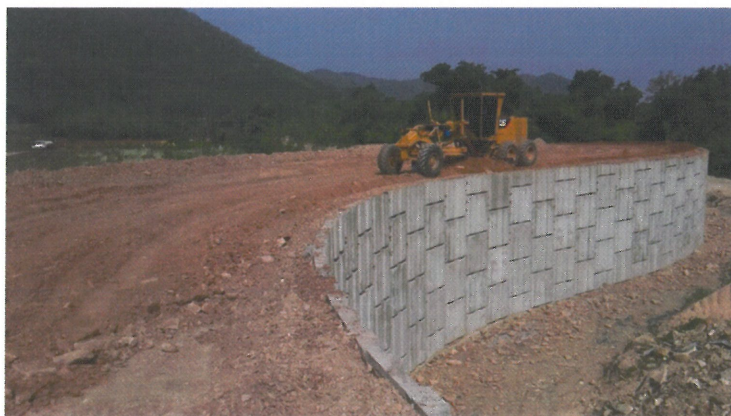
รูปที่ ๔.๓.๑ การติดตั้งแผ่นคอนกรีตแถวสุดท้าย
