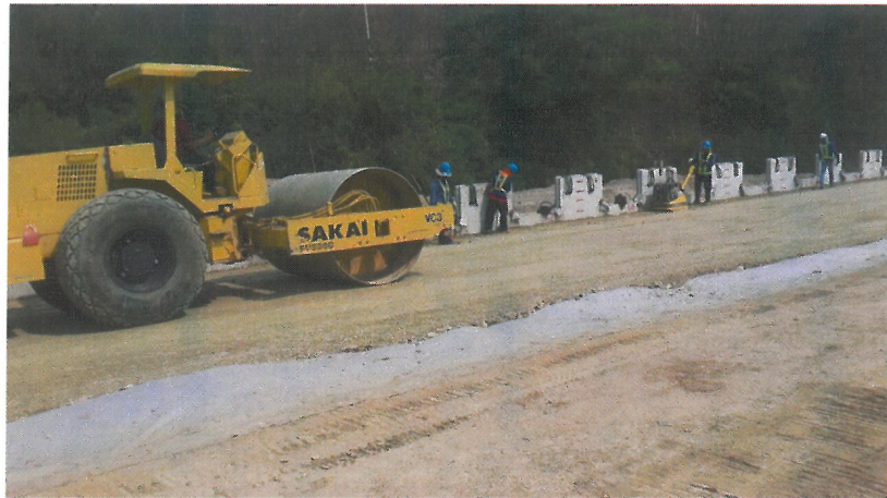
รูปที่ ๔.๑.๙ การบดอัดหลังจากยัดแถบวัสดุเสริมกำลัง (GeoStrap)
