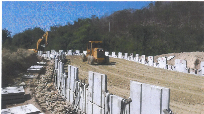
รูปที่ ๔.๑.๑๐ การถมและบดอัดดินถมเสริมกำลังก่อนติดตั้งแผ่นคอนกรีตแถวที่ ๒
