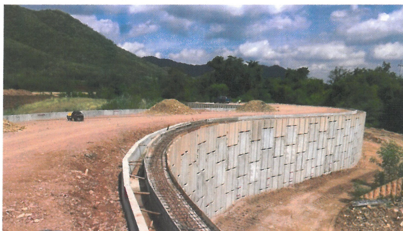
รูปที่ ๔.๓.๒ การหล่อและติดตั้ง (Coving)
