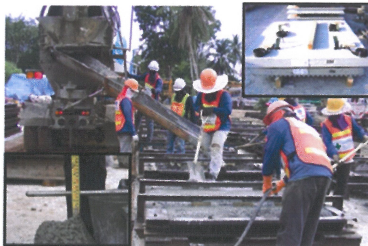
รูปที่ ๒.๑ การหาค่ากำลังอัดประลัย และการหาค่ายุบตัวของคอนกรีต (Concrete)
