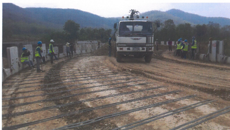
รูปที่ ๔.๑.๘ การยึดแถบวัสดุเสริมกำลัง (GeoStrap)
