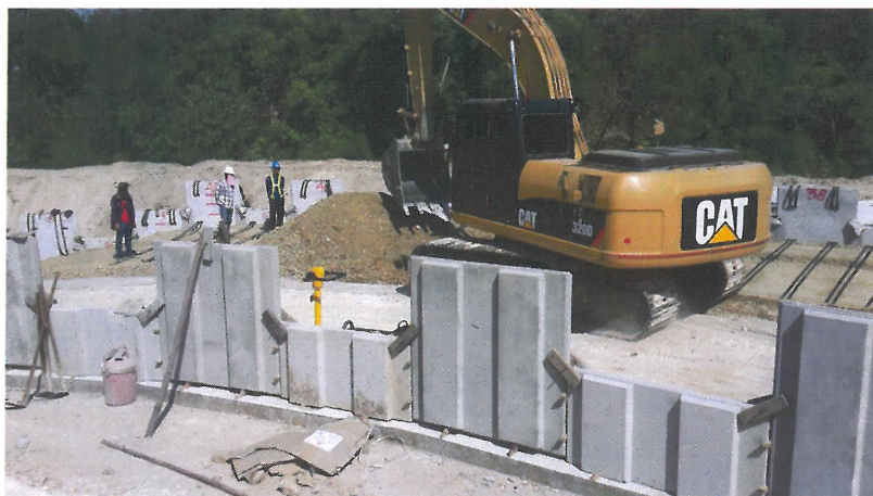
รูปที่ ๔.๑.๓ การยึดแผ่นคอนกรีต
