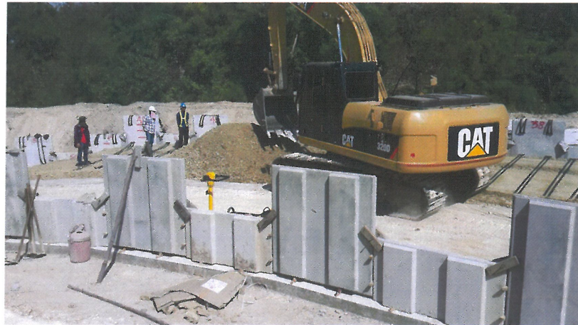
รูปที่ ๔.๒.๔ การปิดรอยต่อระหว่างแผ่นคอนกรีตต่อจากแผ่นคอนกรีตที่ ๑
