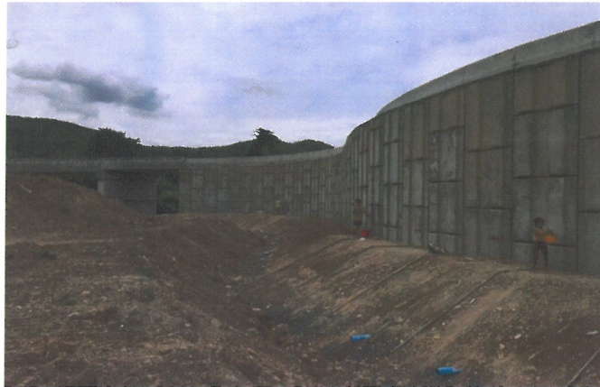
รูปที่ ๔.๒.๖ การถมดินหน้ากำแพง
