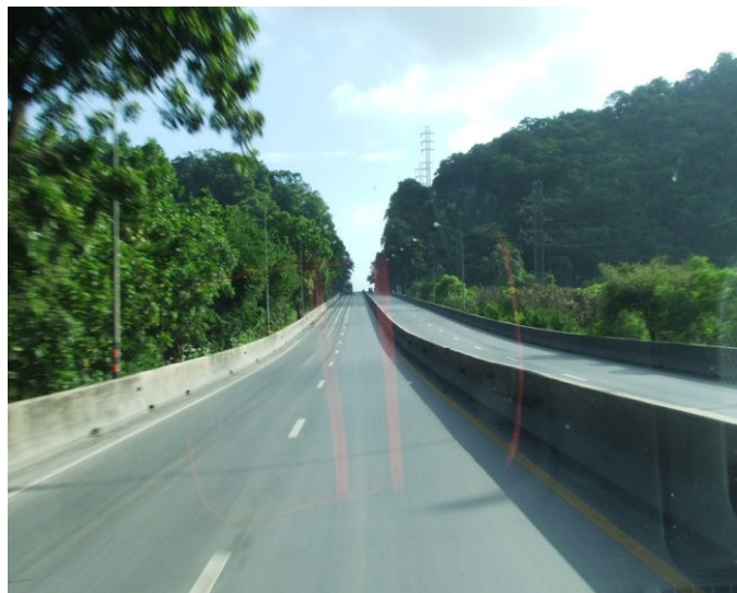
รูปที่ 26 ราวกันของเกาะกลางแบบ Concrete Barrier
