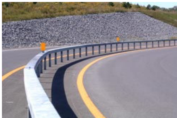
รูปที่ 22 ราวกันของเกาะกลางแบบราวเหล็ก Box Beam
