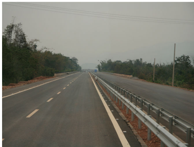
รูปที่ 20 ราวกันของเกาะกลางแบบแผ่นเหล็ก Steel Beam Guard Rail (W-Beam)
