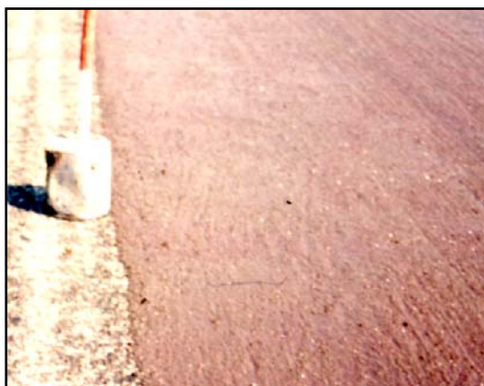
รูปที่ 2.4.5 ผิวทางแบบ Slurry Seal ที่บ่มและแห้งแล้ว
