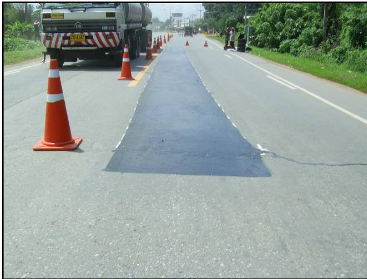
รูปที่ 2.2.3 ผิวทางเมื่อทำการฉาบผิวทางแบบฟ็อกซีลเสร็จ รอเปิดจราจร
