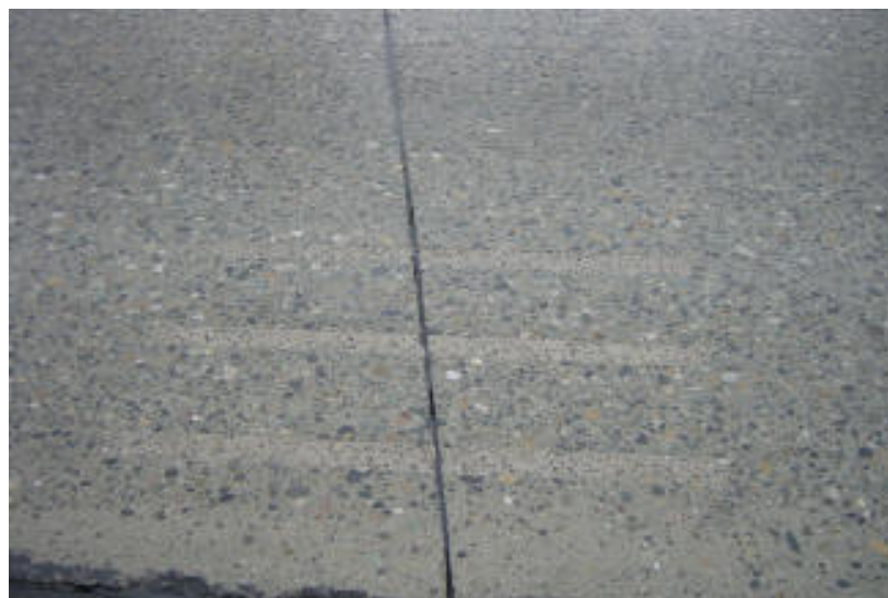
รูปที่ 3.4.5 ขัดผิวหลังการติดตั้งเหล็กเดือย
