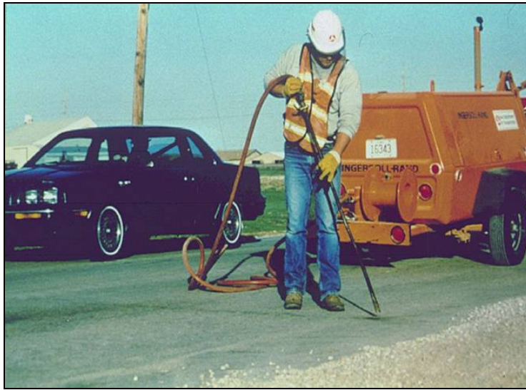
รูปที่ 3.1.2 ทำความสะอาดรอยต่อ
