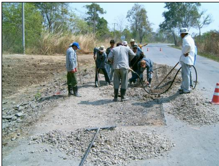
รูปที่ 2.6.2 ขุดรื้อชั้นผิวทางและชั้นที่ชำรุดเสียหายออก
