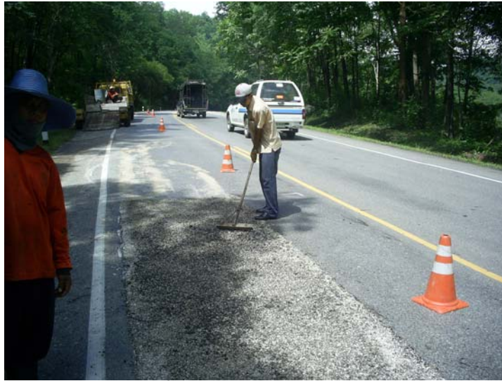
รูปที่ 2.3.5 เกี่ยหีนย้อยให้กระจายอย่างสม่ำเสมอ
