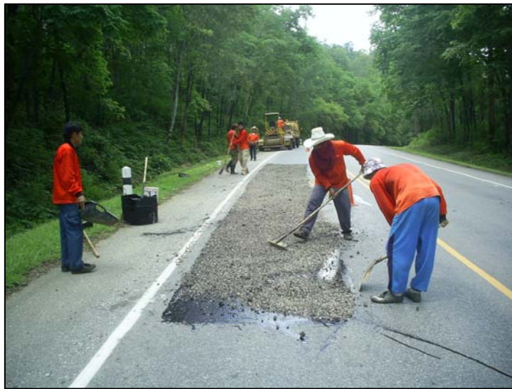
รูปที่ 2.3.3 โรยหินย่อยหรือกรวดย่อยปิดทับหน้าแอสฟัลต์
