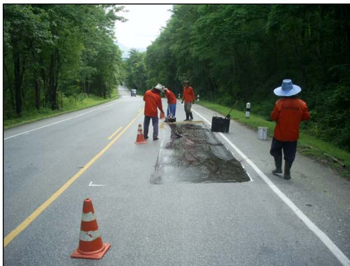
รูปที่ 2.3.2 ลาดแอสฟัลต์ที่เตรียมไว้
