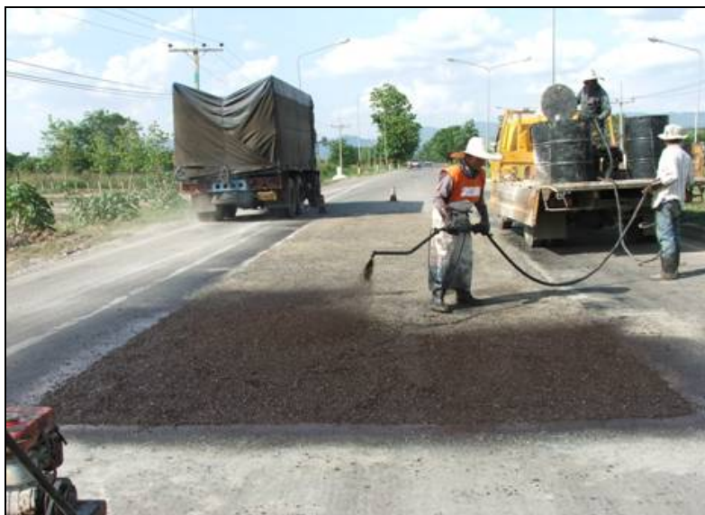
รูปที่ 2.7.3 กรณีปูด้วย Cold Mix อากาศราดแอสฟัลต์เพื่ออุดช่องว่าง
