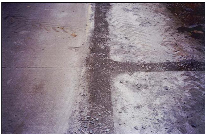
รูปที่ 7 กดทับให้แน่น
