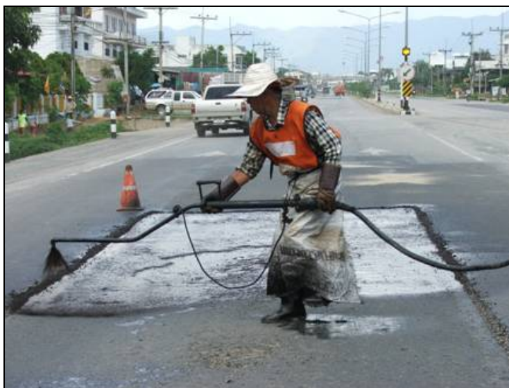
รูปที่ 2.7.1 Tack Coat บนผิวทางเดิมที่ได้กำหนดขอบเขตพื้นที่และทำความสะอาดแล้ว
