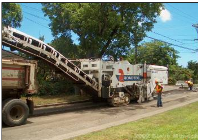
เครื่องจักรขุดไส (Milling Machine) สำหรับขุดไสถนนเอาส่วนที่เสียหายออก
