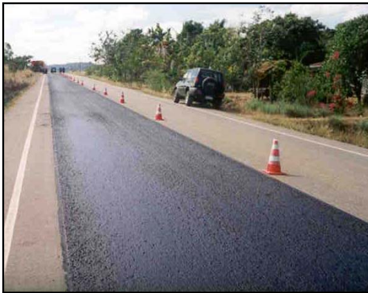
รูปที่ 2.4.4 ผิวทางแบบ Slurry Seal ที่เพิ่งฉาบเสร็จ
