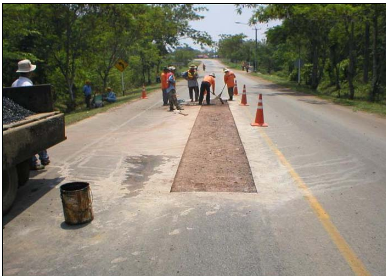
รูปที่ 2.5.2 รอยตัดต้องเรียบและตั้งฉาก
