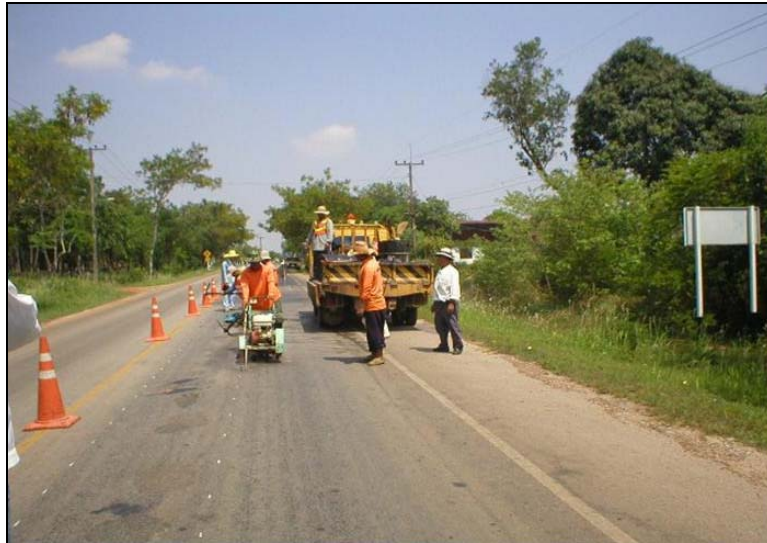
รูปที่ 2.5.1 ตัดขอบตามพื้นที่ๆ จะทำการปะซ่อม
