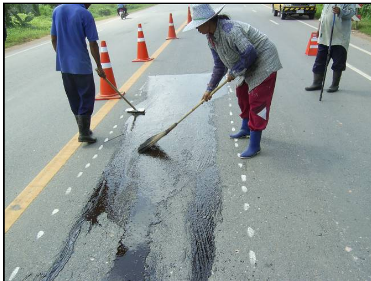
รูปที่ 2.2.2 ทำการฉาบผิวทางด้วยวัสดุที่เตรียมไว้
