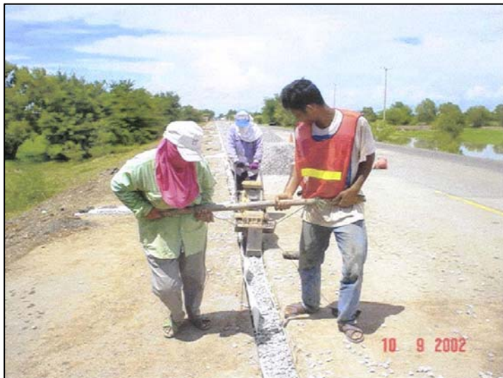
รูปที่ 6 ปูทับด้วยหินคลุกผสมซีเมนต์
