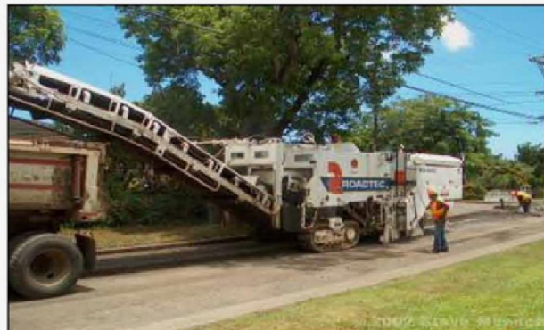
เครื่องจักรขุดไผ่ (Milling Machine) สำหรับขุดไผ่ถนนเอาส่วนที่เสียหายออก
