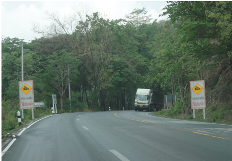
รูปที่ 9 ป้ายเตือน “ทางลงลาดชัน ใช้เกียร์ต่ำ”
