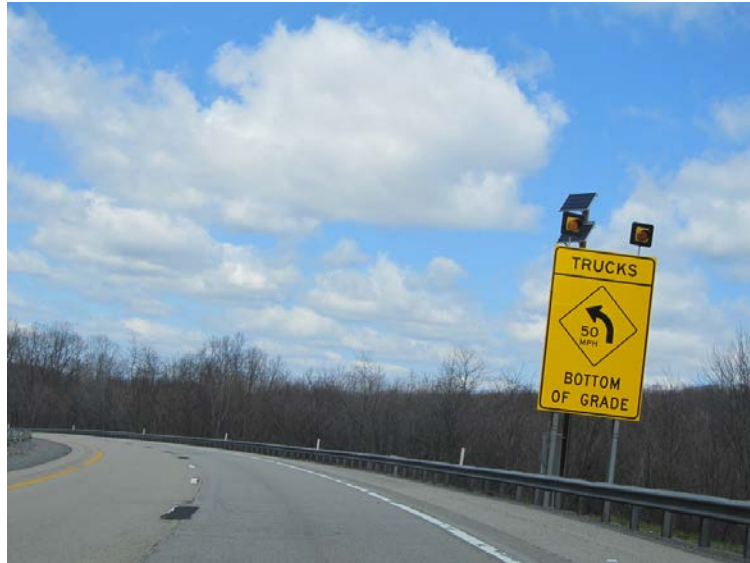
รูปที่ 14 การติดตั้งไฟกระพริบคู่กับป้ายเตือน
