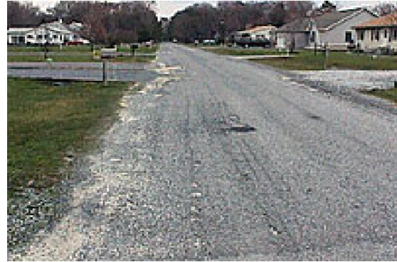
รูปที่ 21 ความเสียหายประเภทผิวทางหลุดร่อน
