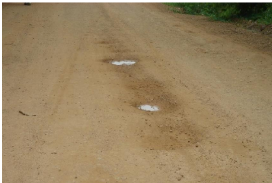
รูปที่ 46 ความเสียหายผิวทางลูกรังประเภทหลุมบ่อ
