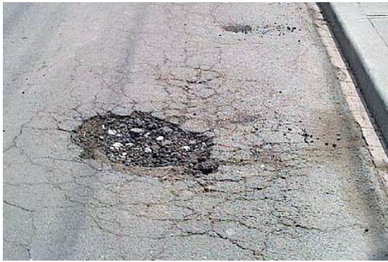
รูปที่ 8 ความเสียหายประเภทหลุมบ่อ
