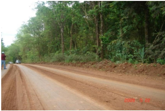
รูปที่ 47 ความเสียหายผิวทางลูกรังประเภทร่องล้อ
