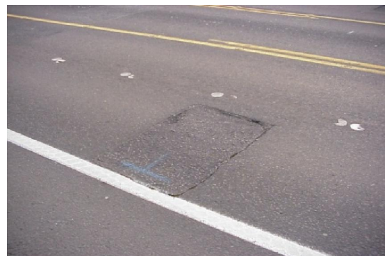
รูปที่ 18 ความเสียหายประเภทรอยปะซ่อมที่เสียหาย
