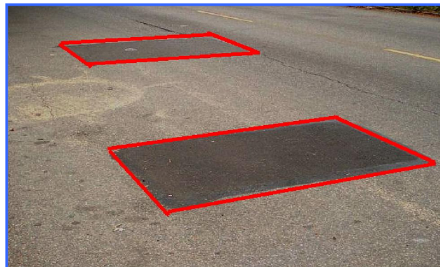
รูปที่ 20 ตัวอย่างการวัดปริมาณความเสียหายประเภทรอยปะซ่อมที่เสียหาย
