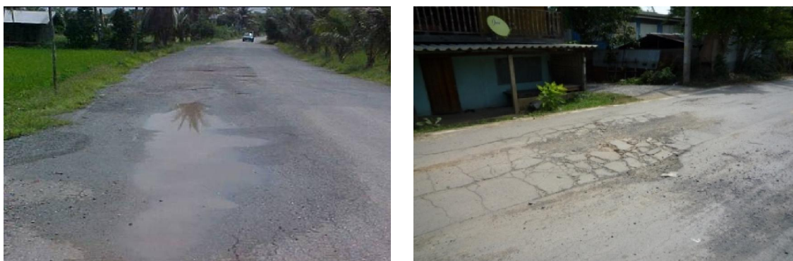
รูปที่ 11 ความเสียหายประเภทยุบตัวเป็นแอ่ง
