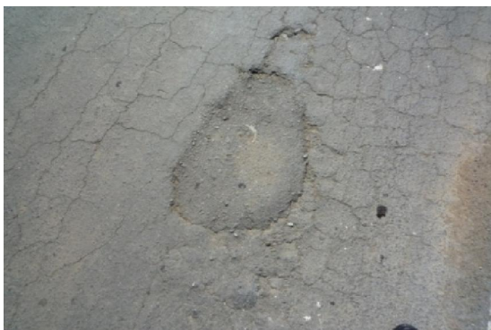
รูปที่ 18 ความเสียหายประเภทรอยปะซ่อมที่เสียหาย
