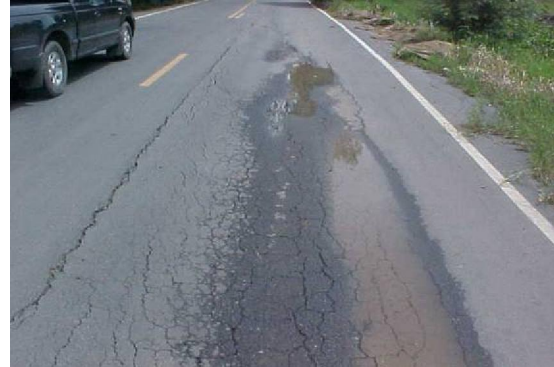
รูปที่ 28 ความเสียหายประเภทรอยแตกร้าวแบบหนังจระเข้
