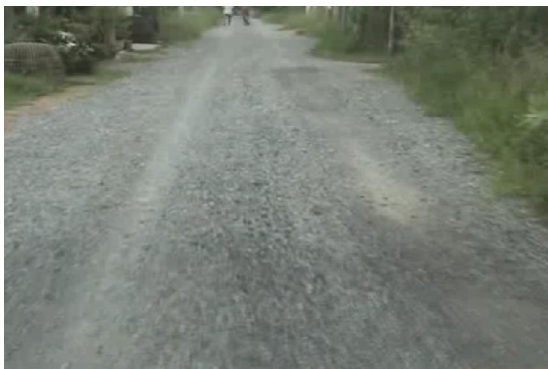
รูปที่ 48 ความเสียหายผิวทางลูกรังประเภทผิวทางหลุดร่อน
