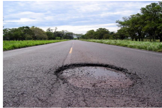
รูปที่ 8 ความเสียหายประเภทหลุมบ่อ
