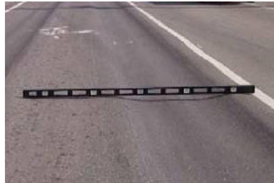
รูปที่ 14 ความเสียหายประเภทร่องล้อ
