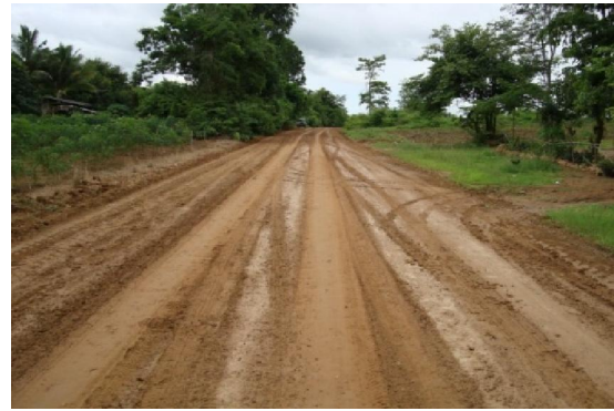
รูปที่ 47 ความเสียหายผิวทางลูกรังประเภทร่องล้อ
