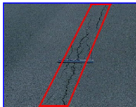
รูปที่ 27 ตัวอย่างการวัดปริมาณความเสียหายประเภทรอยแตกตามยาว / ขวาง
