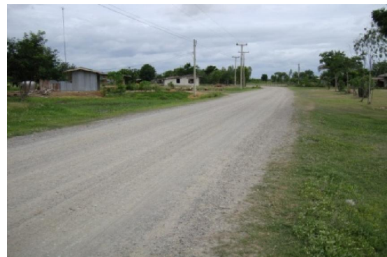
รูปที่ 48 ความเสียหายผิวทางลูกรังประเภทผิวทางหลุดร่อน
