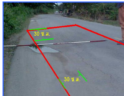
รูปที่ 13 ตัวอย่างการวัดปริมาณความเสียหายประเภทยุบตัวเป็นแอ่ง
