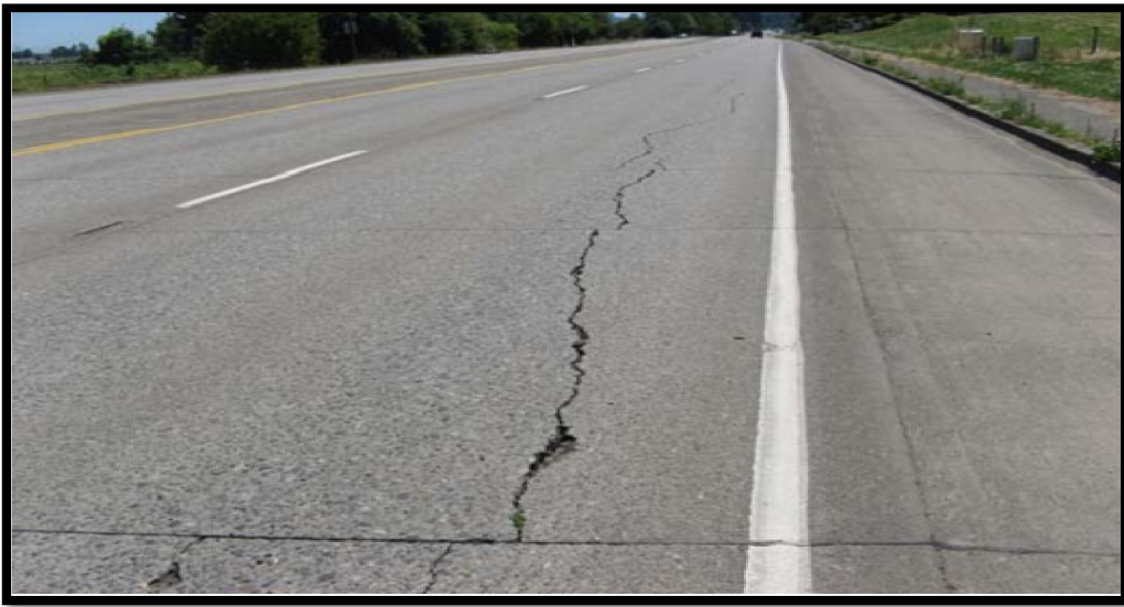
รูปที่ 32 ความเสียหายผิวทางคอนกรีตประเภทรอยแตกตามยาว
