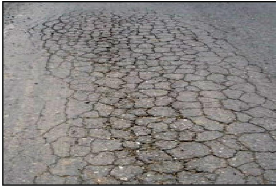
รูปที่ 28 ความเสียหายประเภทรอยแตกร้าวแบบหนังจระเข้
