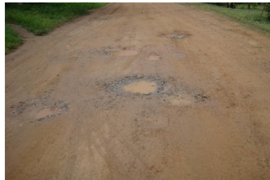
รูปที่ 46 ความเสียหายผิวทางลูกรังประเภทหลุมบ่อ
