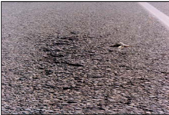
รูปที่ 21 ความเสียหายประเภทผิวทางหลุดร่อน
