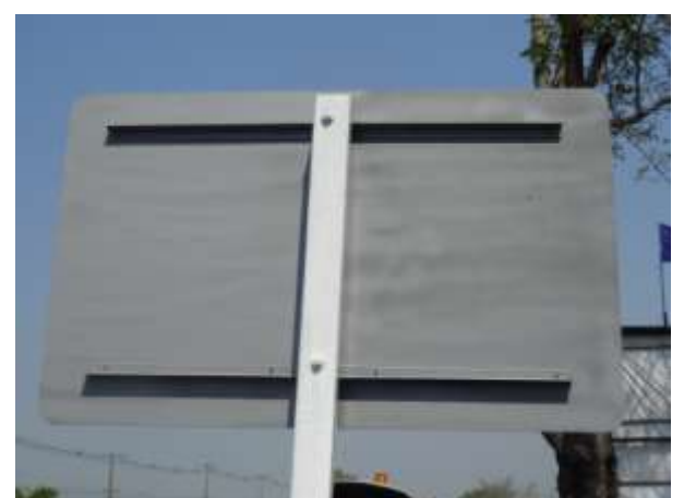
พ่นสีเทาหลังป้ายที่เป็นสนิมและลบเลือน
