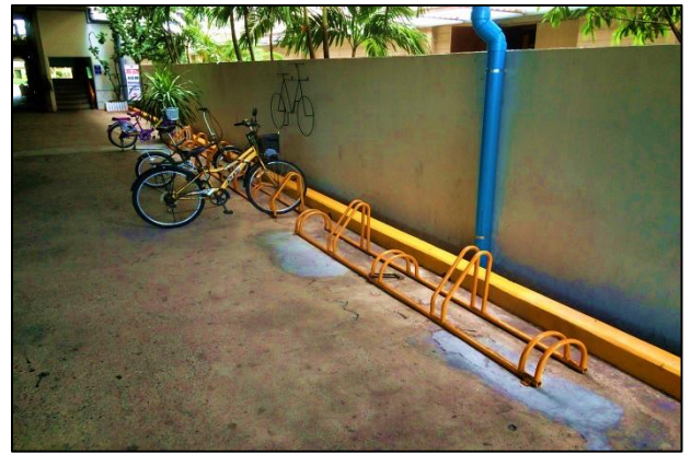
รูปที่ 2 (ข) โครงยึดจักรยานที่ไม่แนะนำ เพราะสามารถผูกยึดได้เฉพาะล้อจักรยาน
