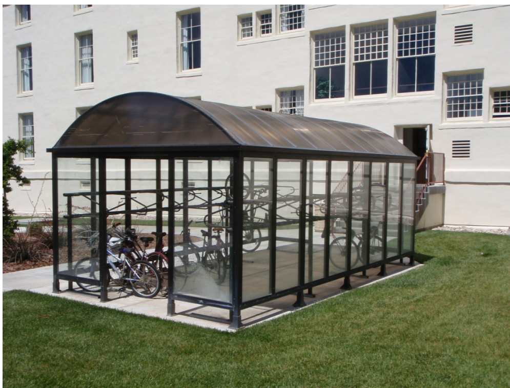
รูปที่ 5 ตัวอย่างหลังคาคลุมที่จอดจักรยาน
