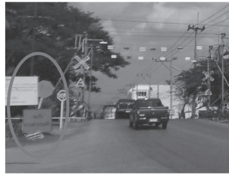
รูปที่ S3a-1 ป้ายจราจรไม่ชัดเจน ชำรุด และไม่ได้มาตรฐาน
