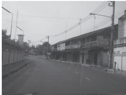
รูปที่ P3a - 1 แสดงภาพของบริเวณที่มีระยะมองเห็นปลอดภัยไม่เพียงพอ
