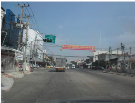
รูปที่ M4a-1 เส้นจราจรไม่ชัดเจน
