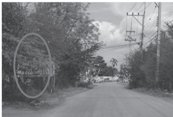
รูปที่ S3a-2 ป้ายจราจรถูกบดบัง
