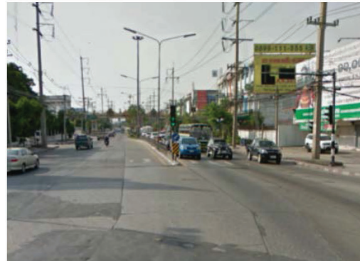
รูปที่ P7a - 1 เกาะกลางที่ออกแบบไม่สอดคล้องกับปริมาณจราจรรถเลี้ยวขวา
