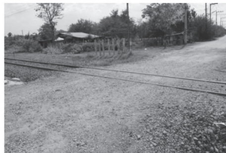
รูปที่ S3d-2 จุดตัดทางรถไฟที่ไม่ติดตั้งเครื่องกัน
