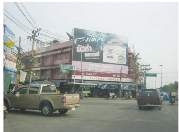
รูปที่ M7a-1 แสดงภาพปัญหาขาดการตีเส้นจราจรและเครื่องหมายบนพื้นทาง
