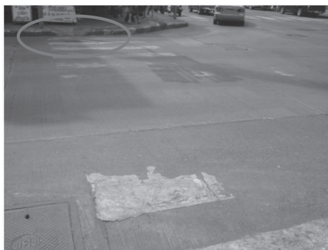
รูปที่ P7b - 2 การติดตั้งลาดทางบริเวณทางเท้าที่ไม่ได้มาตรฐาน
