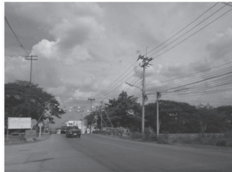
รูปที่ S3c-1 สิ่งกีดขวางบดบังระยะมองเห็นปลอดภัยของผู้ขับขี่บริเวณจุดตัดทางรถไฟ
