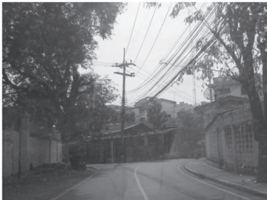
รูปที่ P3a - 1 แสดงภาพของบริเวณที่มีระยะมองเห็นปลอดภัยไม่เพียงพอ
