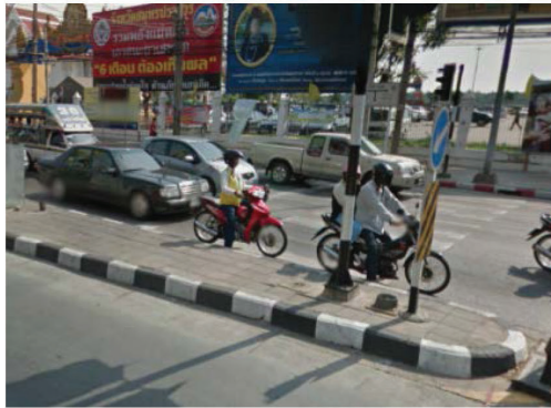
รูปที่ P7a - 1 เกาะกลางที่ออกแบบไม่สอดคล้องกับปริมาณจราจรรถเลี้ยวขวา
