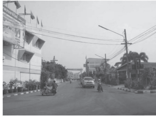
รูปที่ M6a-1 ทางแยกที่ไม่มีการตีเส้นแบ่งช่องจราจรและเครื่องหมายบอกทิศทาง
