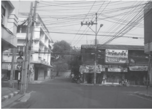
รูปที่ M6a-1 ทางแยกที่ไม่มีการตีเส้นแบ่งช่องจราจรและเครื่องหมายบอกทิศทาง
