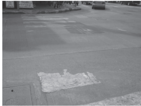
รูปที่ P7b - 1 เส้นทางคนข้ามไม่ชัดเจน ขรุขระ และไม่ได้มาตรฐาน
