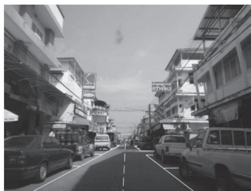
รูปที่ S2c-2 แสดงการแก้ปัญหาโดยการตีเส้นจราจรบนถนนที่มีเส้นจราจรไม่ชัดเจน
