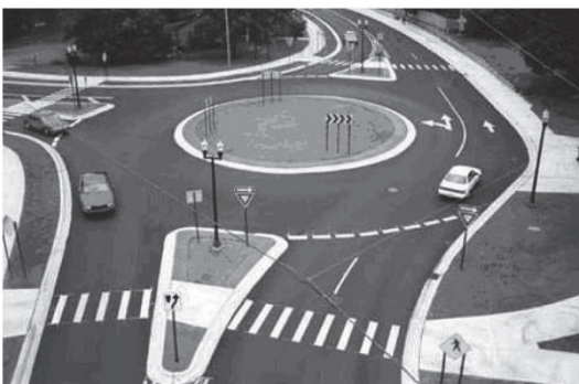
รูปที่ P8b - 2 การติดตั้งเส้นทางคนข้ามและทางเดินเท้าบริเวณวงเวียน
