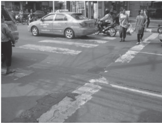
รูปที่ P7b - 1 เส้นทางคนข้ามไม่ชัดเจน ขรุขระ และไม่ได้มาตรฐาน
