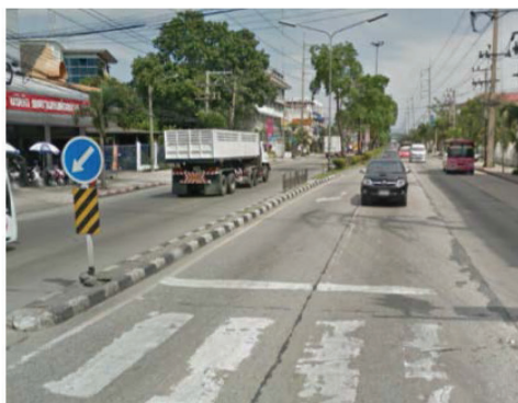
รูปที่ P7a - 2 การออกแบบเกาะกลางที่ได้มาตรฐาน
