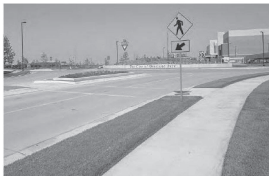
รูปที่ P8b - 2 การติดตั้งเส้นทางคนข้ามและทางเดินเท้าบริเวณวงเวียน
