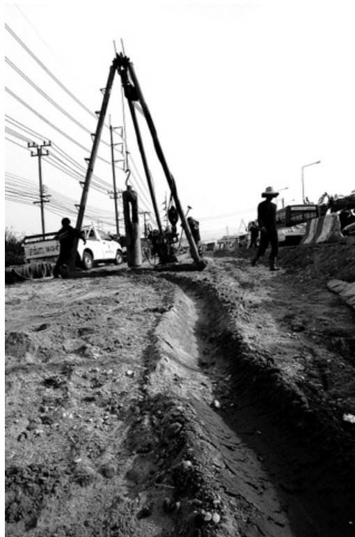
รูปที่ 4.19 แสดงการทำเสาเข็มเจาะ
