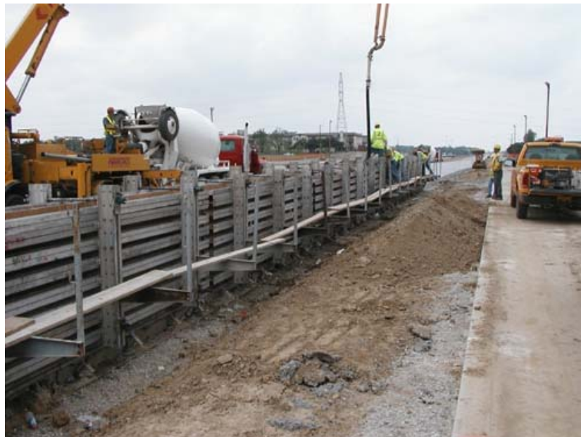
รูปที่ 4.30 แสดงการก่อสร้างกำแพงกันดินบริเวณลาดชันด้านข้างของถนน
