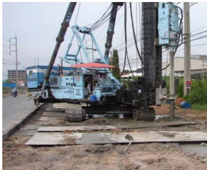
รูปที่ 4.38 เครื่องจักรในการทำเสาเข็มดินซีเมนต์ระบบเปียก
