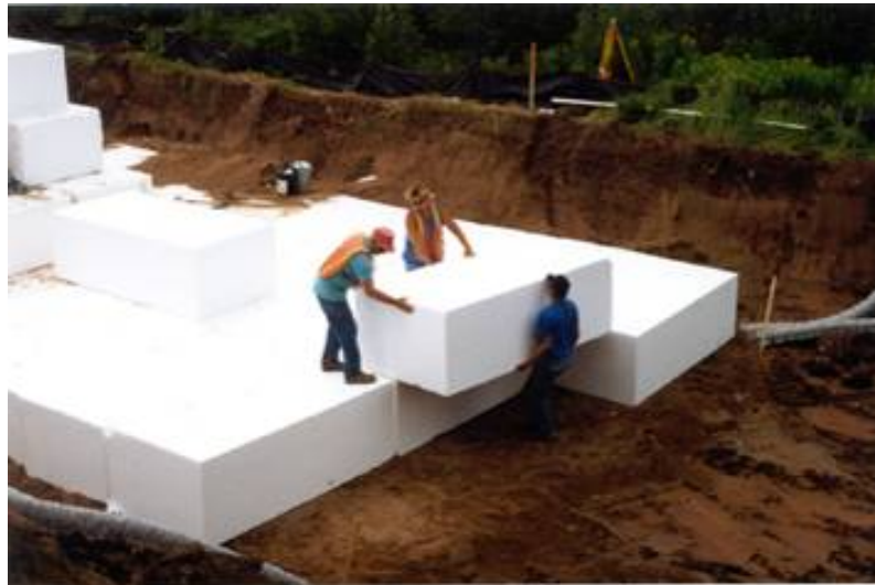
รูปที่ 4.3 แสดงการใช้งาน EPS Block
