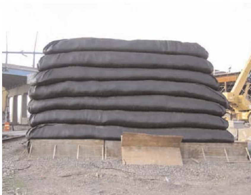
รูปที่ 4.27 การใช้แผ่นใยสังเคราะห์เพื่อทำให้เชิงลาดมีเสถียรภาพ
