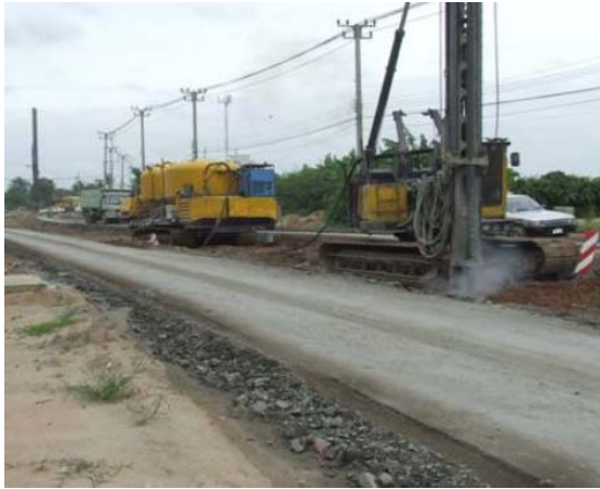
รูปที่ 4.40 เครื่องจักรในการทำเสาเข็มดินซีเมนต์ระบบผสมแห้ง
