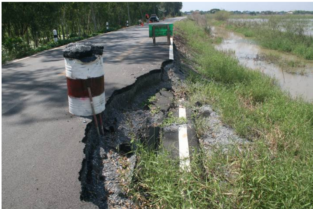
รูปที่ 3.7 ความเสียหายลักษณะการเคลื่อนพังของคันทาง
