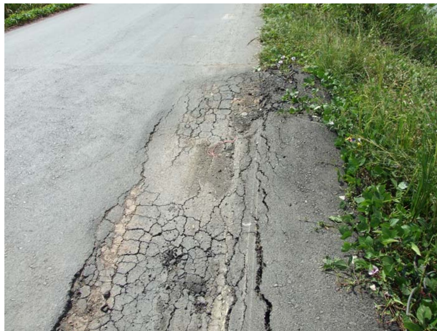
รูปที่ 2.19 สภาพสายทางระดับ C
