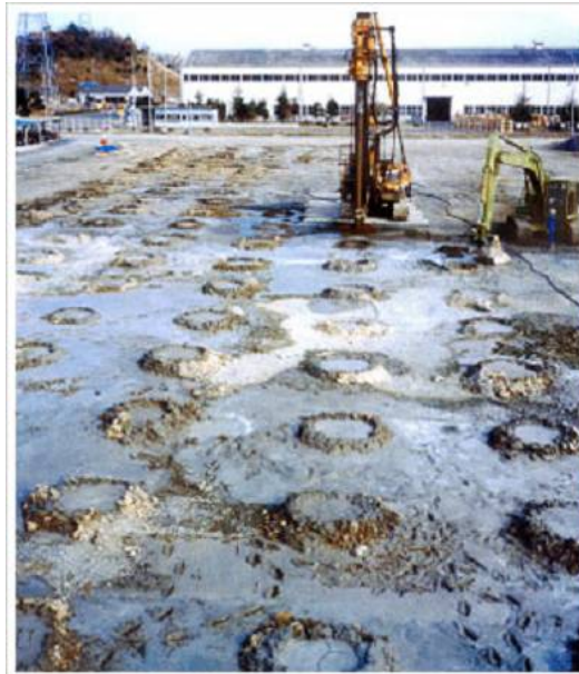
รูปที่ 4.36 แสดงการปรับปรุงคุณภาพดินด้วยเสาเข็มซีเมนต์
