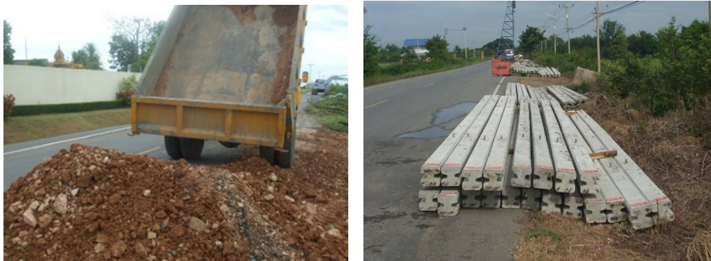
รูปที่ 4.11 แสดงการกองวัสดุไว้บนไหล่ทาง อาจทำให้คันทางทรุดตัวได้
