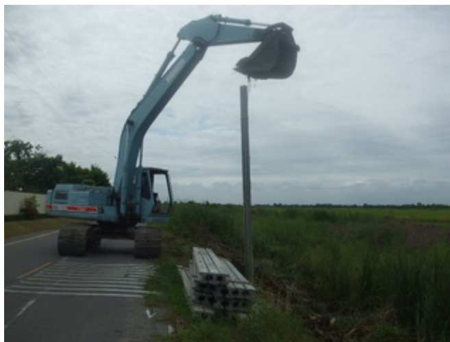
รูปที่ 4.18 แสดงการใช้รถตักดินทำการกดเสาเข็มเพื่อเสริมแรงให้คันทาง
