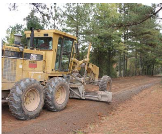
รูปที่ 4.35 การก่อสร้างคันทางบดอัดด้วยดินซีเมนต์
