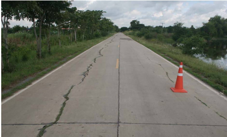
รูปที่ 2.5 รอยแตกที่เกิดขึ้นเนื่องจากการเคลื่อนตัวของคันทาง
