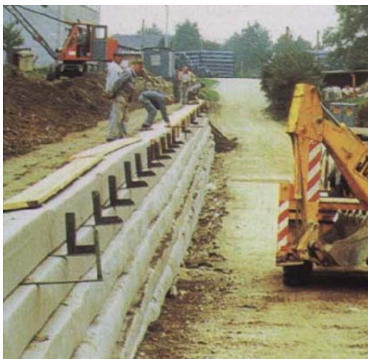
รูปที่ 4.28 การถมดินโดยใช้แผ่นใยสังเคราะห์ช่วยเพิ่มเสถียรภาพ (Polyfelt)
