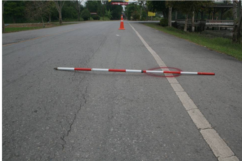
รูปที่ 3.4 แสดงความเสียหายในลักษณะการยุบตัวของคันทาง
