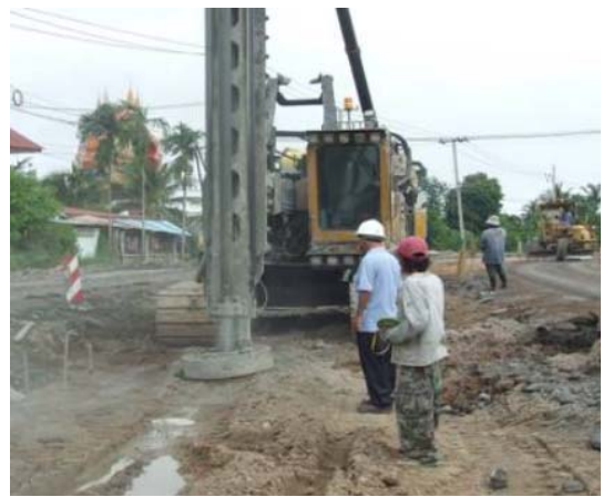
รูปที่ 4.40 เครื่องจักรในการทำเสาเข็มดินซีเมนต์ระบบผสมแห้ง
