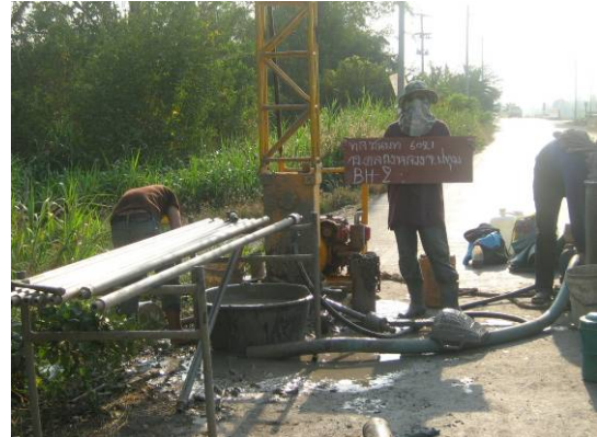
รูปที่ 2.10 แสดงการเจาะสำรวจแบบฉีดล้างด้วยเครื่องโรตารี
