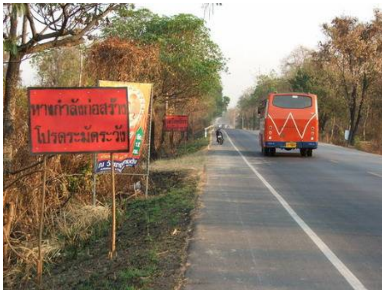
รูปที่ 2.16 งานความปลอดภัยการจราจร
