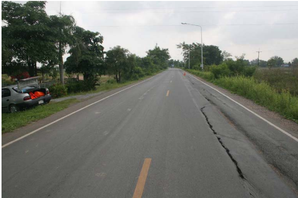
รูปที่ 3.6 รอยแตกที่เกิดขึ้นบนผิวทาง
