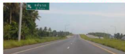
งานก่อสร้างทาง
