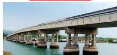
งานก่อสร้างสะพานและท่อเหลี่ยม
