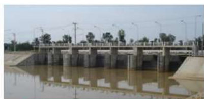
งานก่อสร้างชลประทาน
