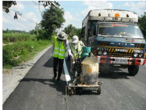
การตีเส้นจราจรด้วยเครื่องจักรแบบปาดลาก
