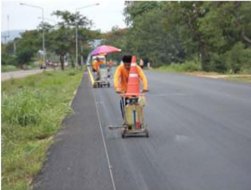
การพ่น Primer ก่อนการตีเส้นจราจร
