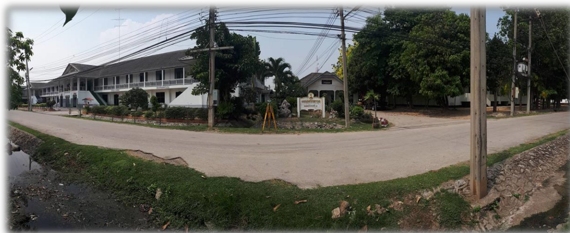
รูป ๑๐ บริเวณพื้นที่ทำการตรวจสอบกล้องระดับ
