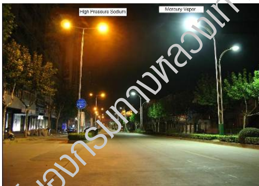
รูปที่ ข-5 เปรียบเทียบไฟฟ้าแสงสว่างทางหลวง แบบโซเดียมความดันไอสูงและแบบปรอทความดันไอสูง
