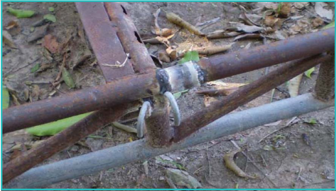
รูปแสดงตะขอเกี่ยวเหล็กแขวนสลิง (เฟรมกลับด้านกับการใช้งาน)
