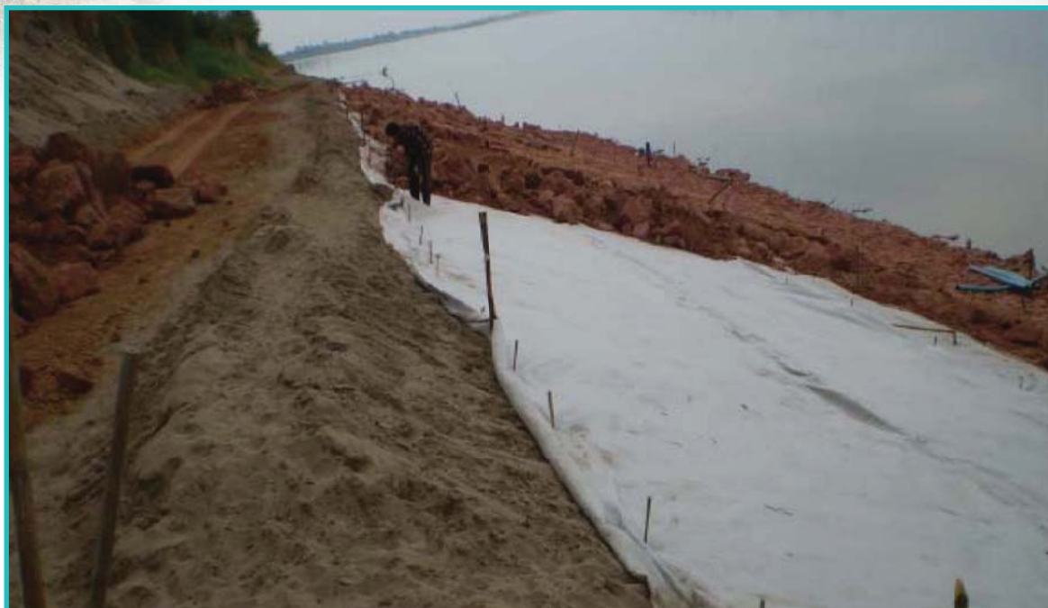
รูปแสดงงานปูแผ่นใยสังเคราะห์ชั้นวัสดุกรอง
