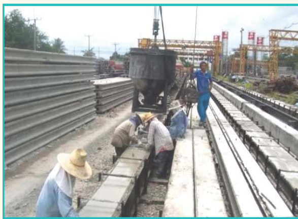
หล่อเสาเข็มเพื่อน
