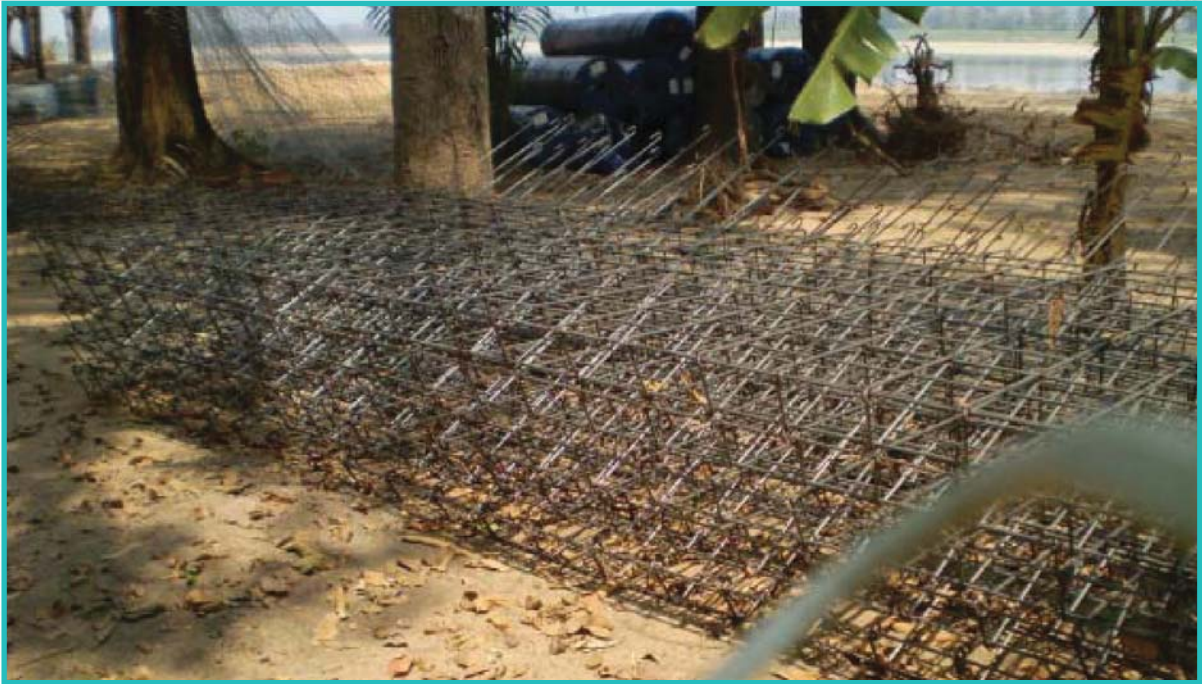
รูปแสดงงานผูกเหล็กเสริมบันไดหน้าเขื่อน
