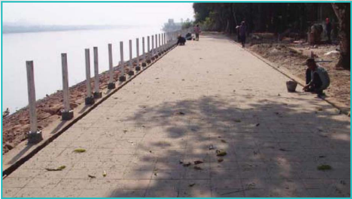
รูปแสดงงานปูคอนกรีตบล็อคล้อมสำเร็จรูปทางเท้า
