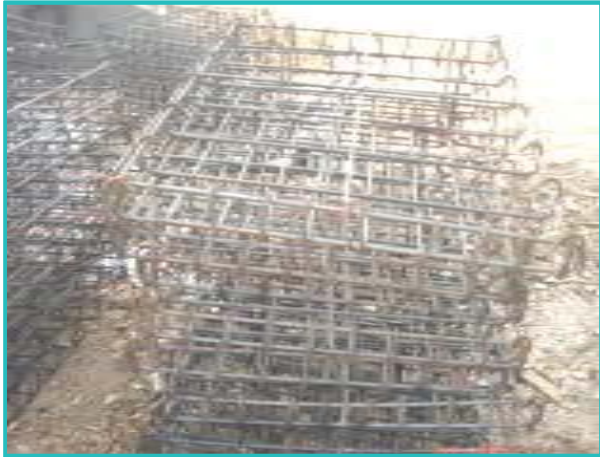
ผูกเหล็กเสริมแผงกร
