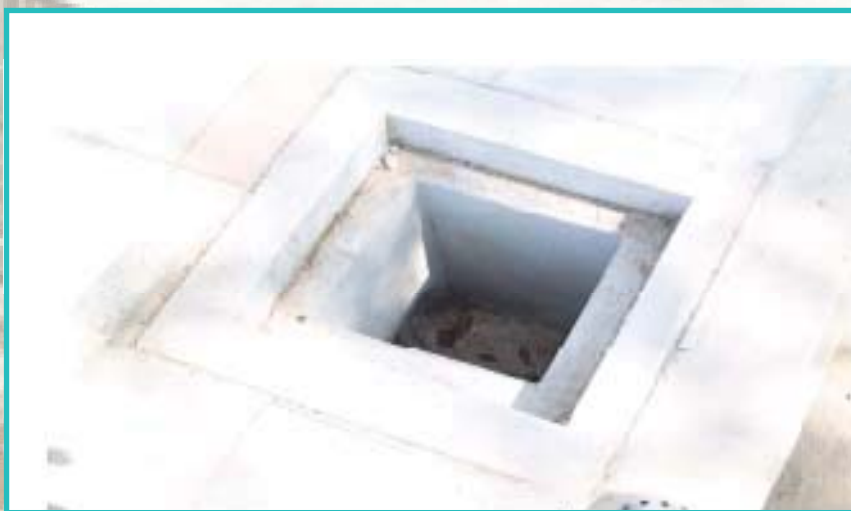
รูปแสดงบ่อพัก คสล. หลังแล้วเสร็จ
