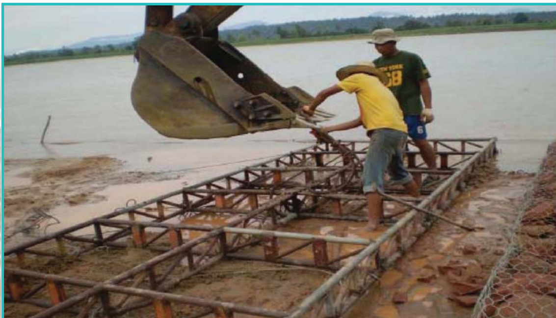
รูปแสดงขั้นตอนผูกสลิงยกเฟรมเข้ากับบั้งที่รัดแบคโค
