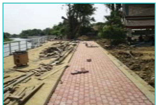
ภาพแสดงงานปูพื้นทางเท้า, งานถมดินและปลุกหน้าหลังเขื่อน
