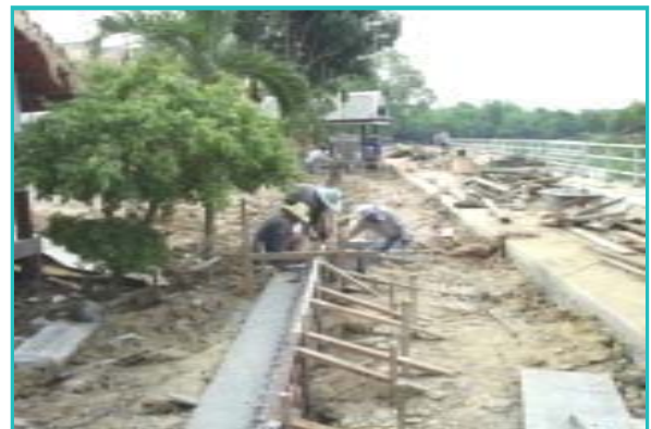
ภาพแสดงงานก่อสร้างระบบระบายน้ำและคันหิน
