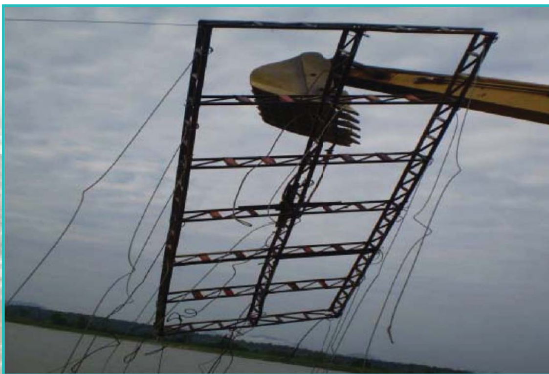
รูปแสดงขั้นตอนยกเฟรมขึ้นจากล่องแม่ทเรสหลังจากปลดห่วงสลิงออกจากตะขอยึดสลิง
