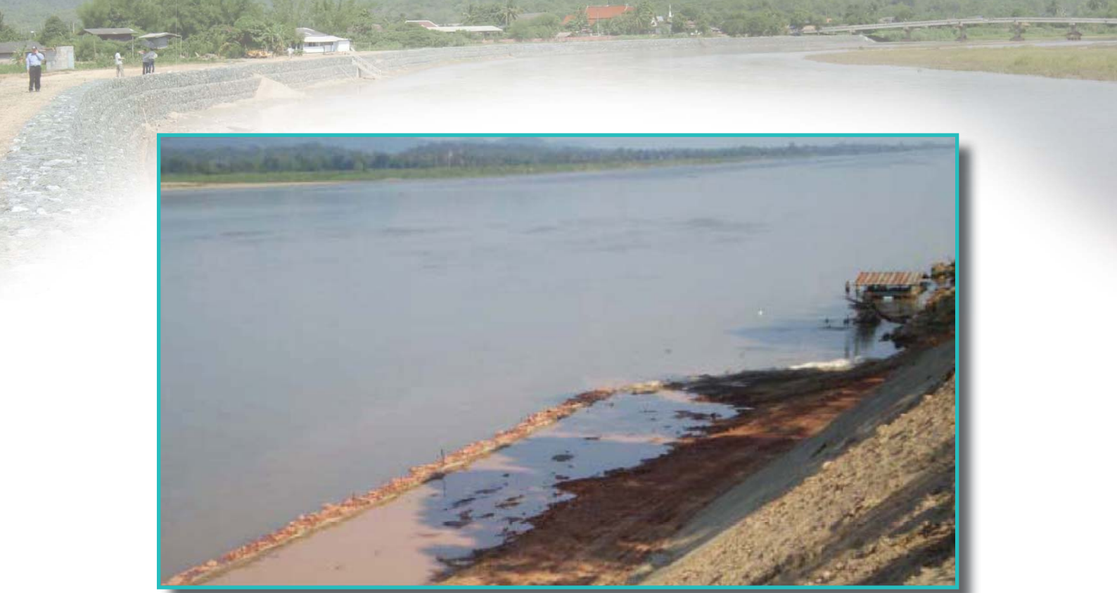
รูปแสดงหลังคันหินทิ้งที่เสริมหินใหญ่แล้วเสร็จ
