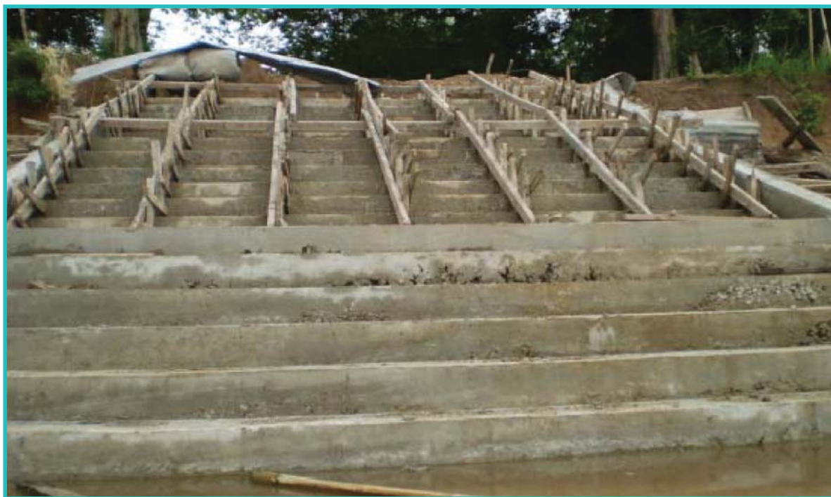
รูปแสดงงานประกอบแบบและเทคอนกรีตลูกขั้นบันได
