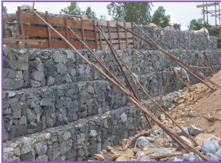
รูป ก่อสร้างกระชหิน (Gabions)
