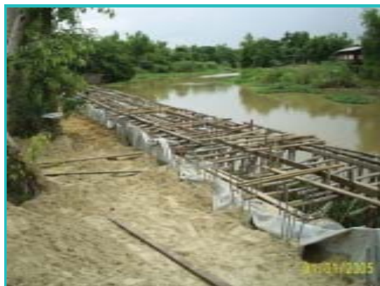
ภาพแสดงการปูแผ่นใยสังเคราะห์และถมทรายหลังเขื่อน
