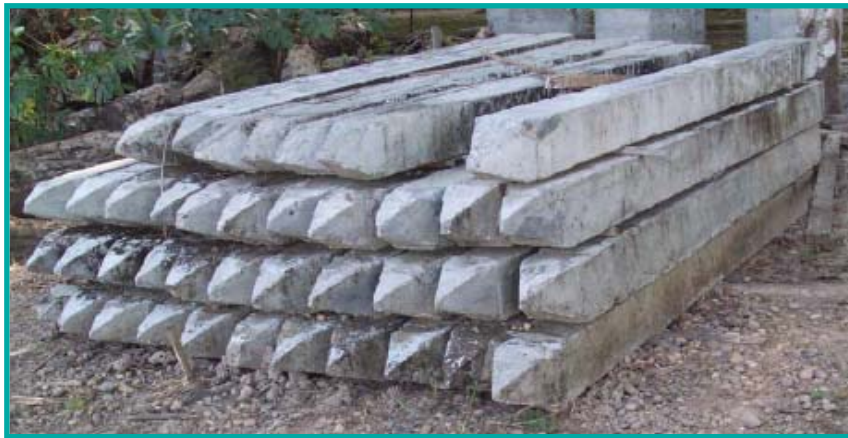
รูปแสดงงานหล่อเสาเข็มขนาด 15*15*2.50 ม.
