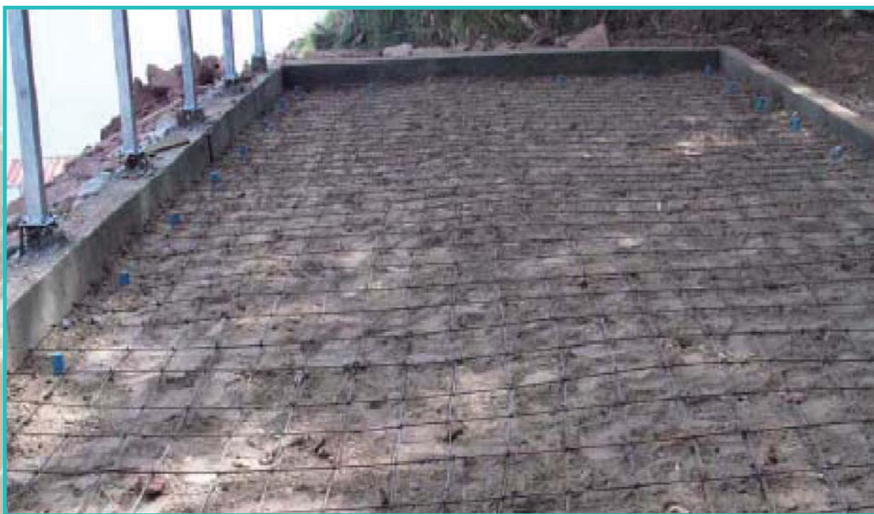
รูปแสดงงานผูกเหล็กเสริมคอนกรีตหยาบรองรับพื้นทางเท้า
