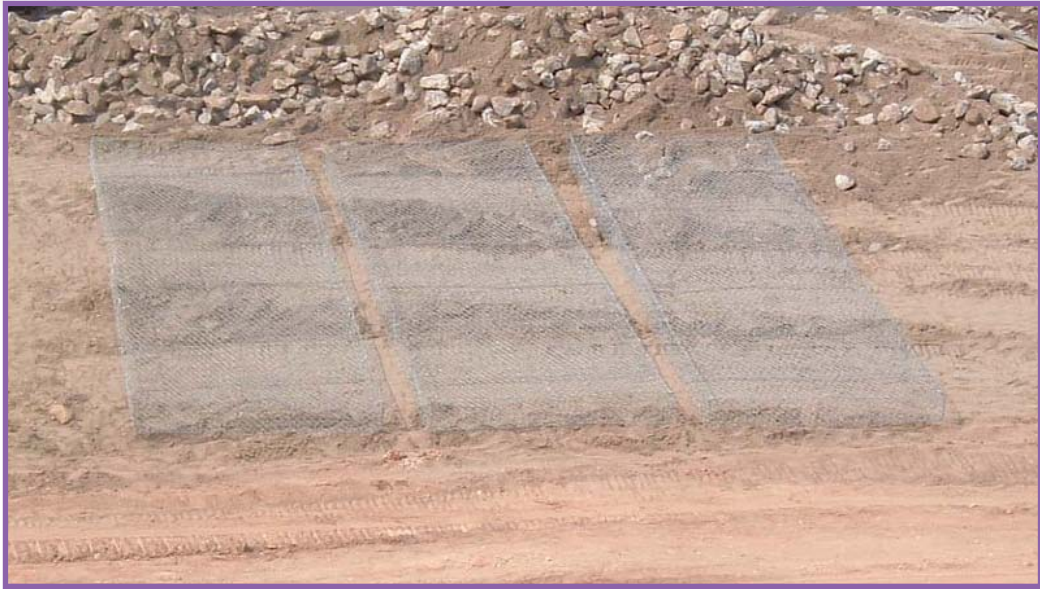
รูปกล่องแมทเทอร์สเมื่อประกอบแล้วเสร็จ
