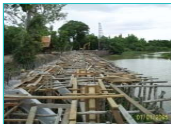
ภาพแสดงงานโครงสร้างคาน B2B ยึดหัวเข็ม, หล่อคานทะแยง B4 และหล่อเสา CX
