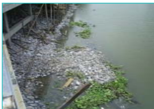
ภาพแสดงงานป้องกันการกัดเซาะหน้าเขื่อน
