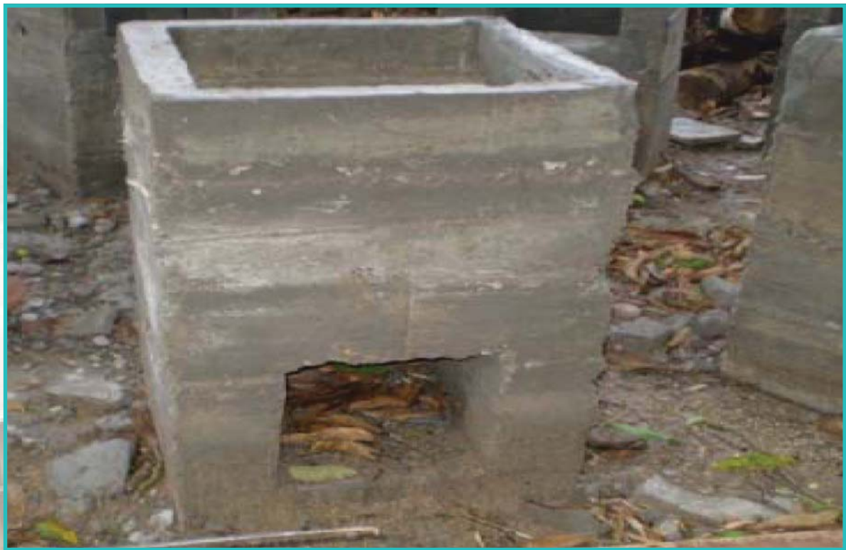
รูปแสดงงานหล่อคอนกรีตบ่อพัก คสล.
