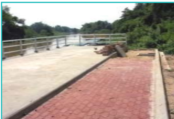
ภาพแสดงงานปูพื้นทางเท้า, งานถมดินและปลุกหน้าหลังเขื่อน
