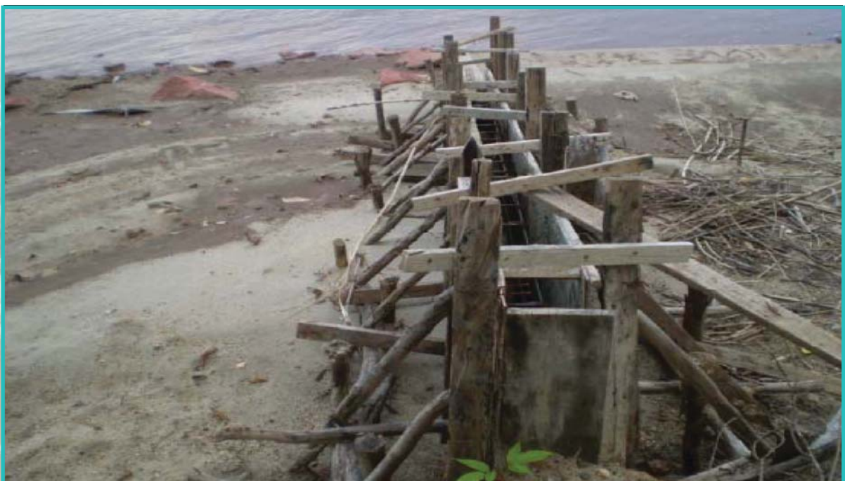
รูปแสดงงานประกอบและผูกเหล็กเสริมคานแม่บันได
