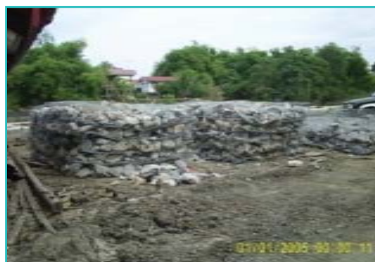
ภาพแสดงขั้นตอนงานงานถมทรายหลังเขื่อนและงานติดตั้ง กล่องลวดตาข่ายเมทเทรสบรรจุหินใหญ่หน้าเขื่อน
