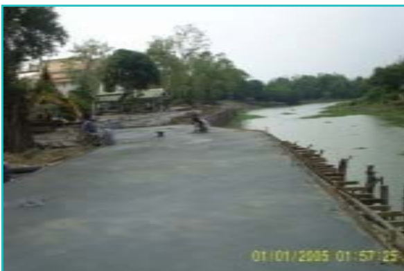
ภาพแสดงงานหล่อพื้นลาน คสล.
