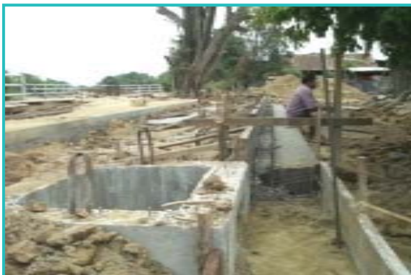
ภาพแสดงงานก่อสร้างระบบระบายน้ำและคันหิน
