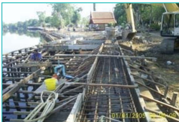
ภาพแสดงงานหล่อโครงสร้างคานยึดหัวเข็ม
