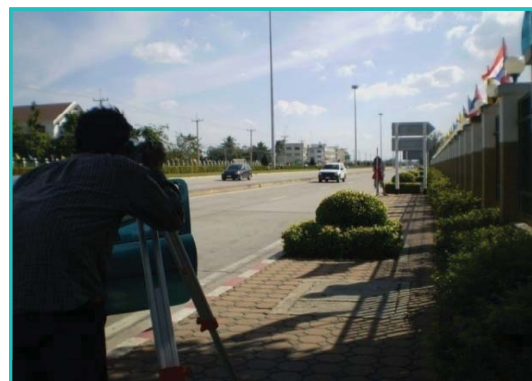
งานถ่ายค่าระดับก่อสร้าง
