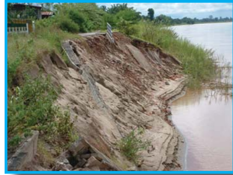
เขื่อนเสียหายจากการเปลี่ยนแปลงท้องน้ำ จ.หนองคาย
