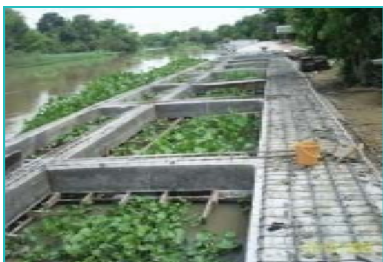
ภาพแสดงขั้นตอนงานงานถมทรายหลังเขื่อนและงานติดตั้ง กล่องลวดตาข่ายเมทเทรสบรรจุหินใหญ่หน้าเขื่อน
