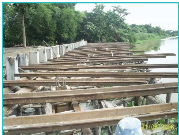
ภาพแสดงการวาง Sheet Pile บนนั่งร้าน เพื่อกระจายน้ำหนักเสริมความแข็งแรง
