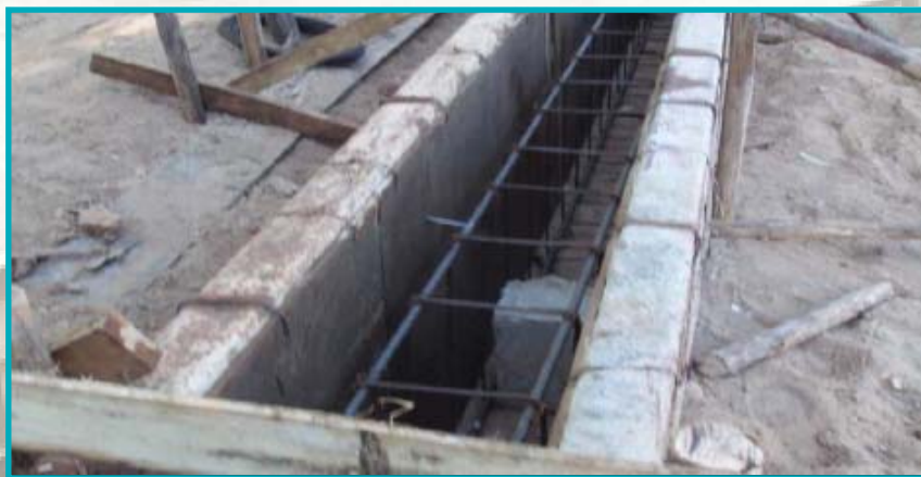
รูปการติดตั้งแบบหล่อและเหล็กเสริมคานรับราวกันตก
