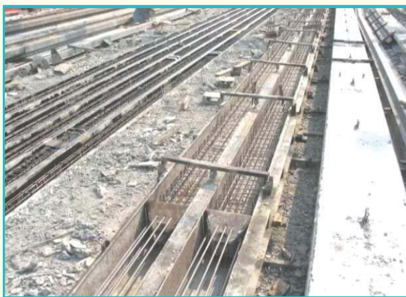
เข้าแบบข้างเสาเข็มเพื่อน
