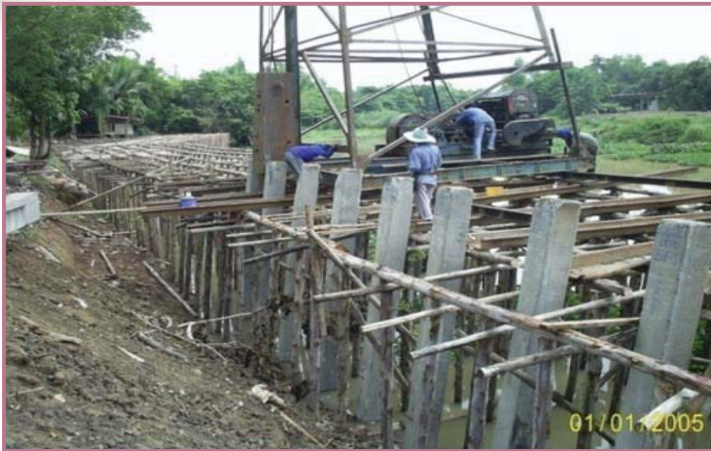
รูป การตอกเสาเข็มสมอเขื่อนแบบโต๊ะ
