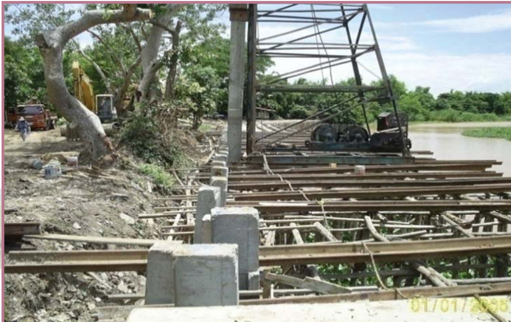
รูป การตอกเสาเข็มหลักเขื่อนแบบโต๊ะ
