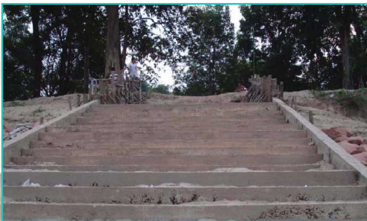
รูปบันไดหลังถอดแบบ
