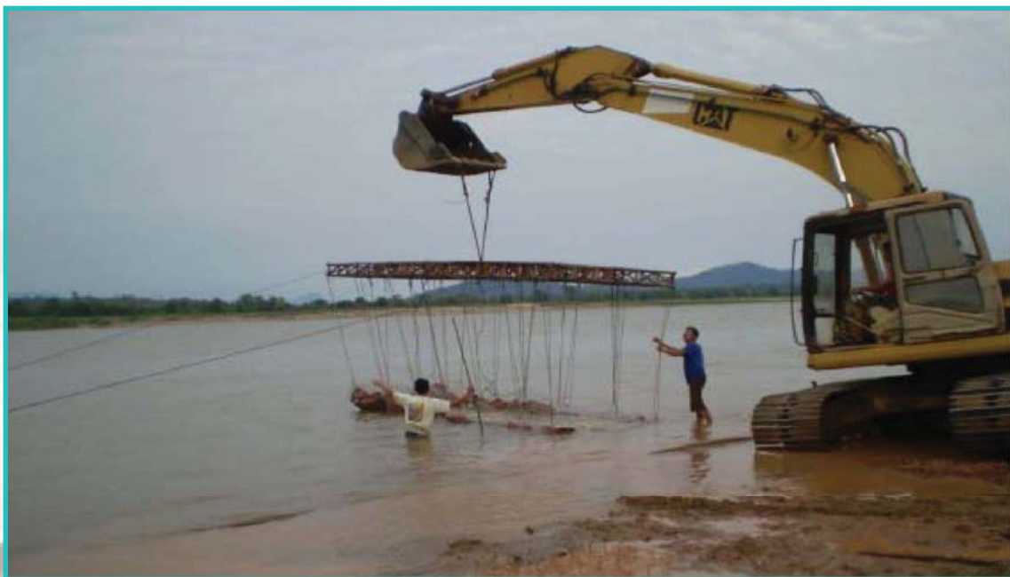
รูปแสดงรถแบคโฮ ยกกล่องเมทเทรลเข้าตำแหน่งติดตั้ง
