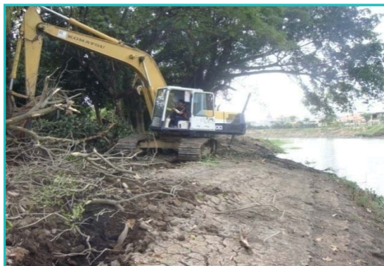
งาน Clearing พื้นที่
