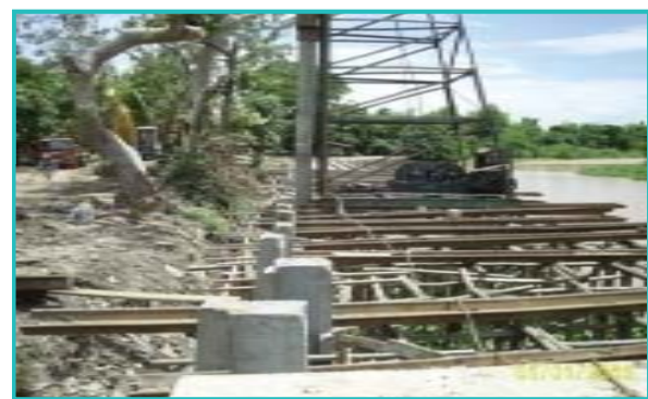
ภาพแสดงงานตอกเสาเข็มหลัก
