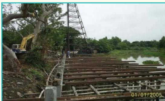
ภาพแสดงวาง SHEET PILEบนนั่งร้านเพื่อ กระจายน้ำหนักเสริมความแข็งแรง
