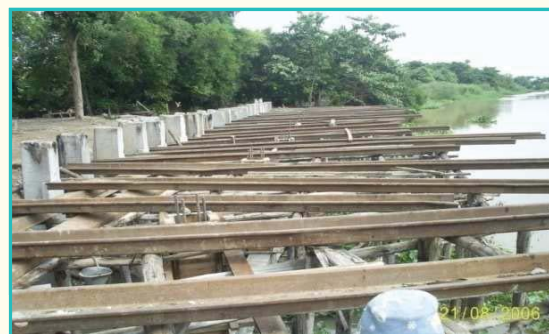
ภาพแสดงวาง SHEET PILEบนนั่งร้านเพื่อ กระจายน้ำหนักเสริมความแข็งแรง
