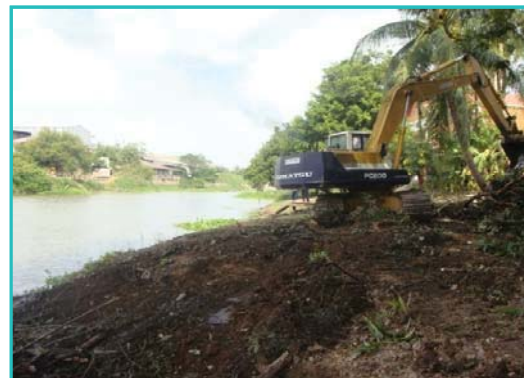
งาน Clearing พื้นที่
