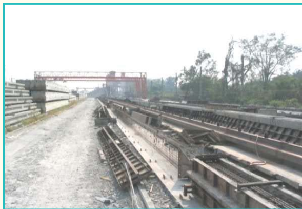
ติดตั้งลวดอัดแรงและผูกเหล็กเสริม
