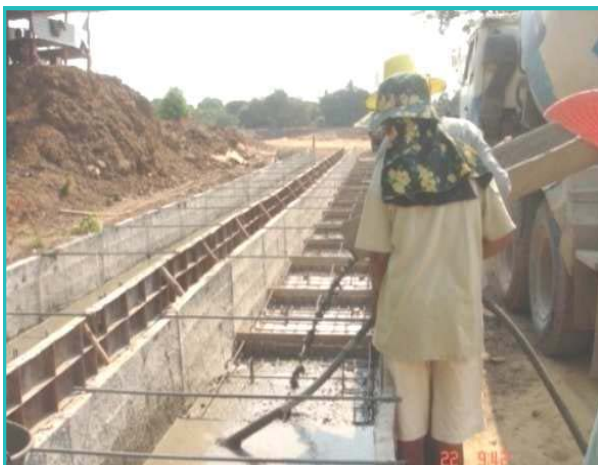
เข้าแบบและหล่อแผงกร
