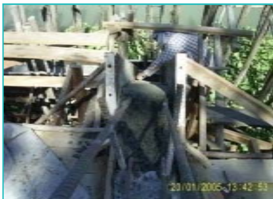
ภาพแสดงงานโครงสร้างคาน B2B ยึดหัวเข็ม, หล่อคานทะแยง B4 และหล่อเสา CX
