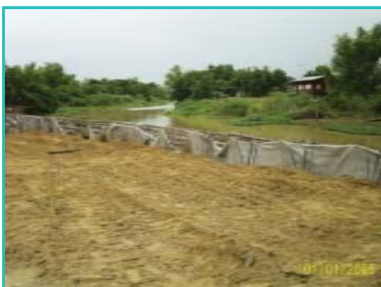
ภาพแสดงการปูแผ่นใยสังเคราะห์และถมทรายหลังเขื่อน
