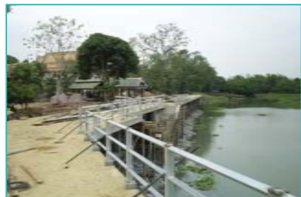
ภาพแสดงงานติดตั้งเสาราวกันตก
