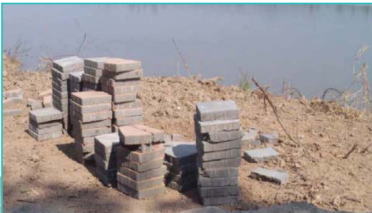
รูปแสดงวัสดุคอนกรีตบล็อกปูพื้นลำเรียงรูป (ศิลาเหลี่ยม ขนาด 0.30*0.30*0.06 ม.)
