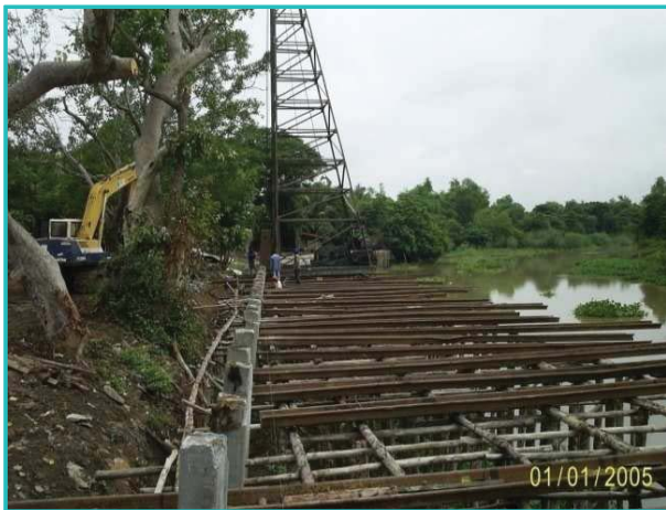
ภาพแสดงการวาง Sheet Pile บนนั่งร้าน เพื่อกระจายน้ำหนักเสริมความแข็งแรง
