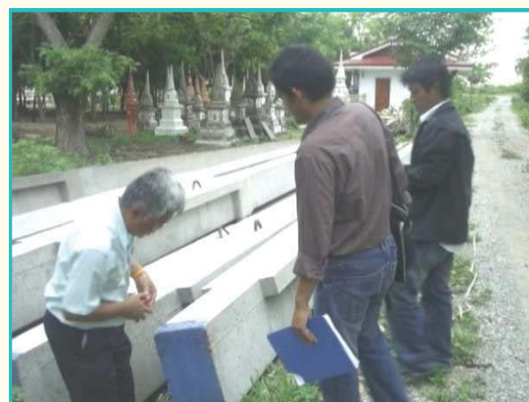
ตรวจสอบขนาดเสาเข็ม
