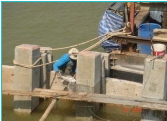
ภาพแสดงการ SAW เสาเข็มเขื่อน
