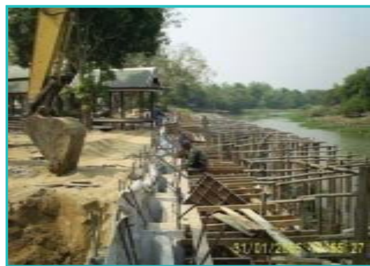
ภาพแสดงการปูแผ่นใยสังเคราะห์และถมทรายหลังเขื่อน
