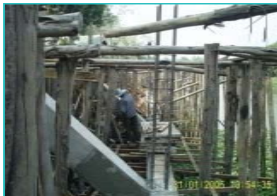
ภาพแสดงงานโครงสร้างคาน B2B ยึดหัวเข็ม, หล่อคานทะแยง B4 และหล่อเสา CX
