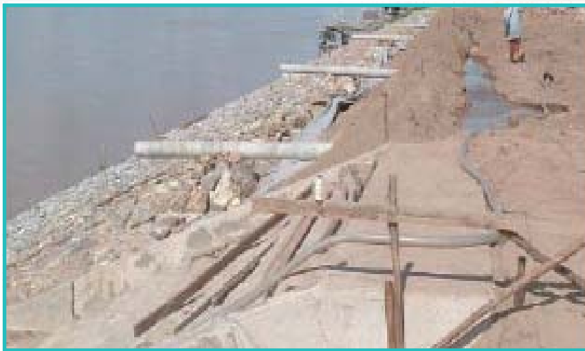
งานติดตั้งท่อระบายน้ำขนาด 20 ซม. หน้าเขื่อน
