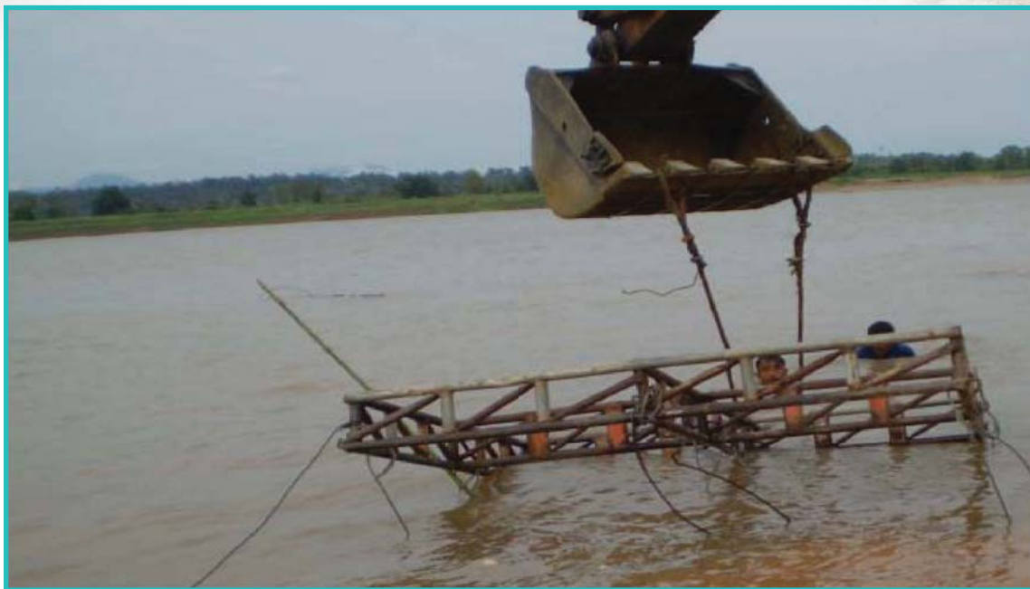
รูปแสดงขั้นตอนขณะปลดปล่อยสิ่งค้ำที่เป็นห่วงออก
