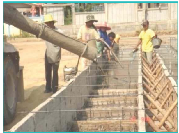
เข้าแบบและหล่อแผงกร
