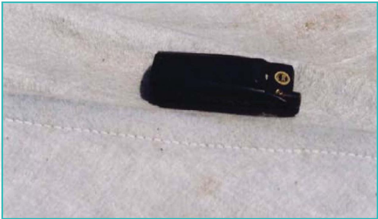
รูปแสดงการต่อแผ่นใยสังเคราะห์ด้วยการเย็บ
