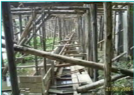
ภาพแสดงงานโครงสร้างคาน B2B ยึดหัวเข็ม, หล่อคานทะแยง B4 และหล่อเสา CX
