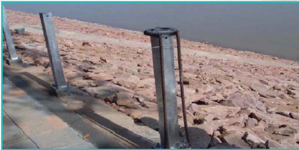
รูปแสดงงานติดตั้งเสารับราวกันตก
