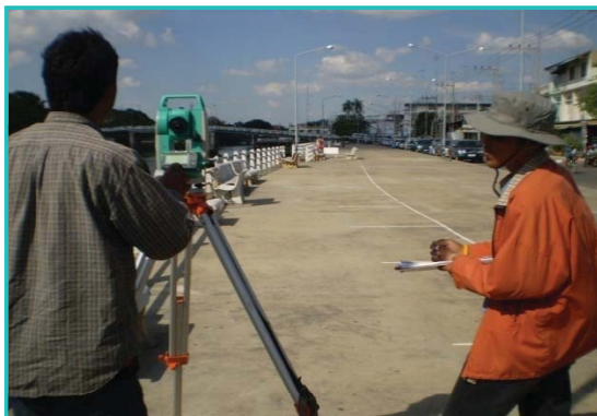
งานสำรวจแนวก่อสร้าง
