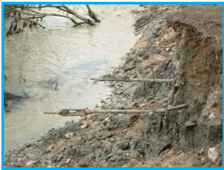
สายสมอยึดเขื่อนชำรุด จ.ฉะเชิงเทรา
