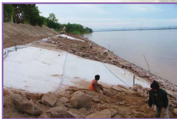
รูป ใช้แผ่นใยสังเคราะห์เป็นวัสดุกรองหน้าเขื่อน
