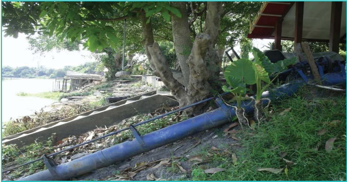
ภาพแสดงสภาพตลิ่งเดิมก่อนการก่อสร้าง
