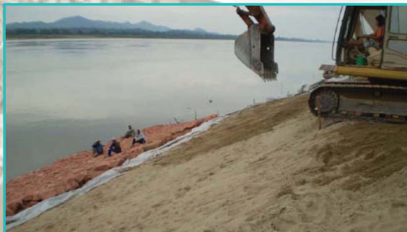
รูปแสดงงานตัด SLOPE ทรายหน้าเขื่อน
