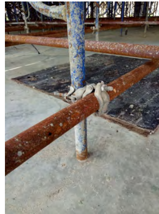
(ข) ไม่ใช่แผ่นรองเสา
