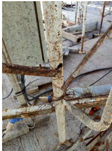
(ช) ใช้ลวดผูกตัวยึดโยงแบบกากบาท
