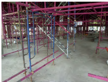
(ค) ตะขอกระไดวางบนพื้นโดยตรง
