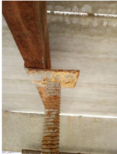
(ง) ใช้ฐานรองรับปรับระดับรูปตัวยูที่เสียหายและใช้ตงที่ไม่พอดีกับฐานรองรับปรับระดับรูปตัวยู
