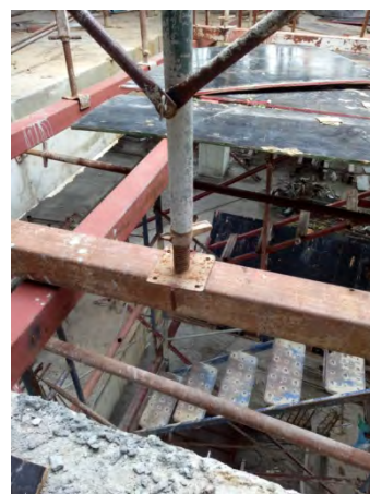
(ฉ) วางแผ่นรองเสาบนเหล็กกล่องที่ลอยอยู่
