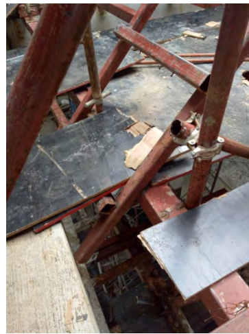
(ข) กระไดไม้วางบนพื้นรองรับ
