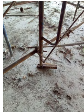
(ง) ใช้เหล็กกล่องรองเสา
