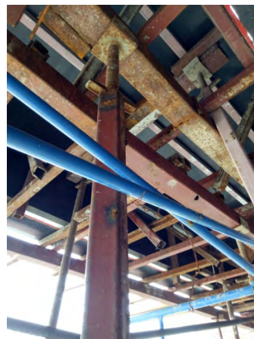
(ง) ใช้เหล็กท่อสี่เหลี่ยมในการค้ำยัน
